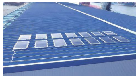
フィルム型ペロブスカイト太陽電池導入実証 画像提供：積水化学工業株式会社
