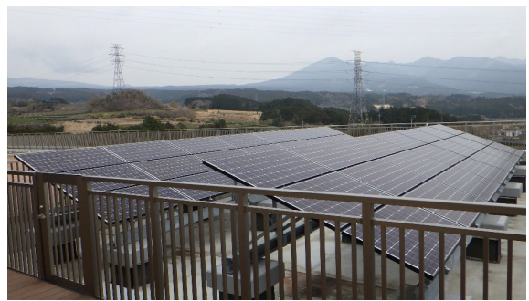
太陽光パネルの設置
