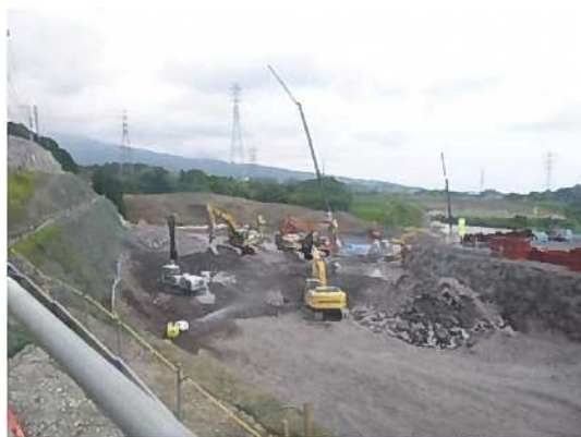
仮設通路工事の状況
