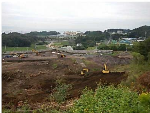
工事区域全景（北側から撮影）
