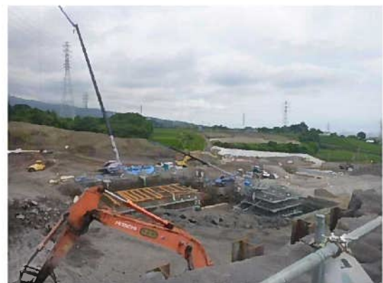
工場棟工事の状況
