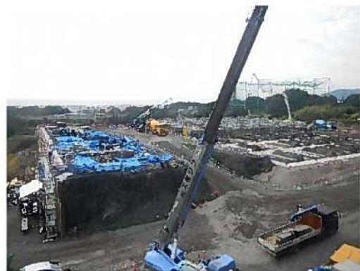
建築工事（計量棟・車庫棟・選別棟）
