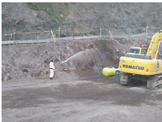
作業員による散水
