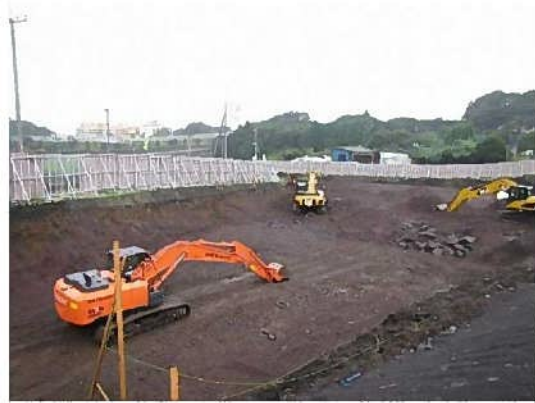
建設機械の稼働状況
