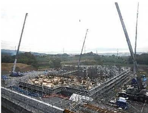
建築工事（工場棟）
