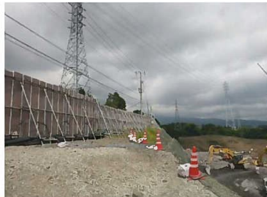
仮囲いの設置
