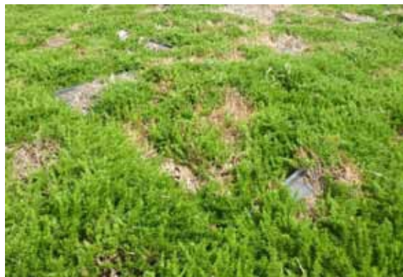
法面下部(近景)
