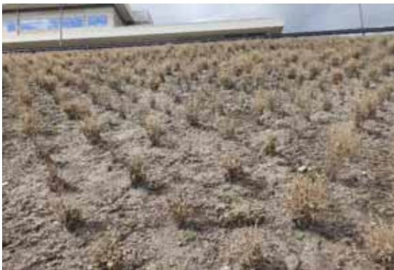
法面上部(近景)
