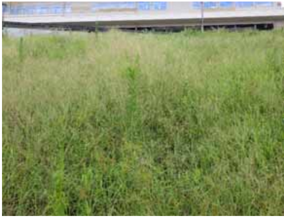
法面上部(遠景)
