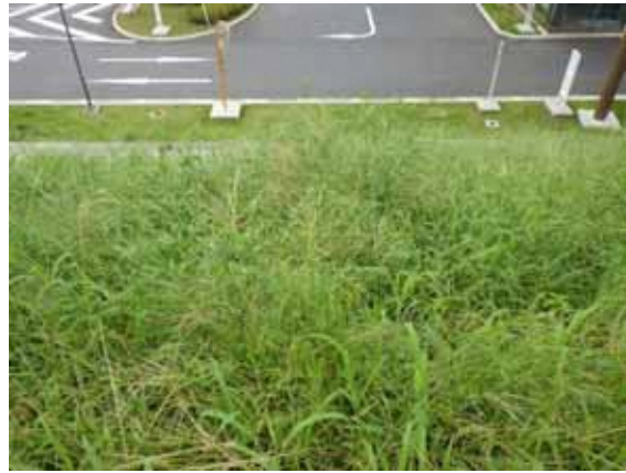
法面下部(遠景)
