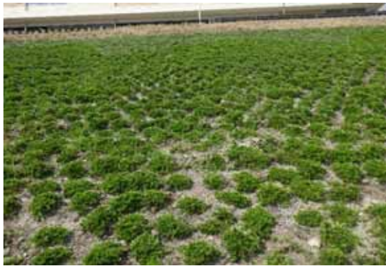
法面上部(遠景)
