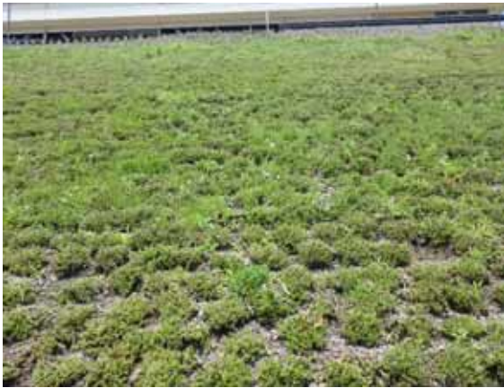
法面上部(遠景)
