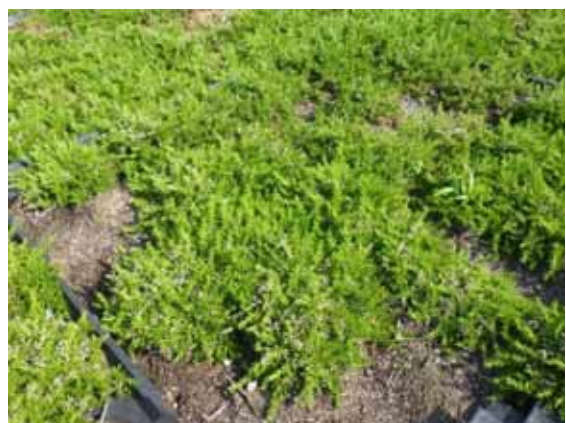
法面下部(近景)
