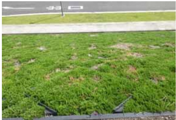
法面下部(遠景)
