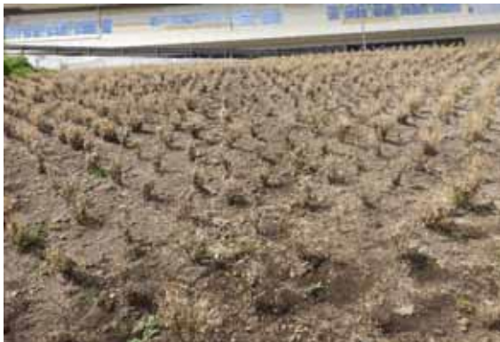
法面上部(遠景)
