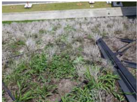
法面下部(近景)
