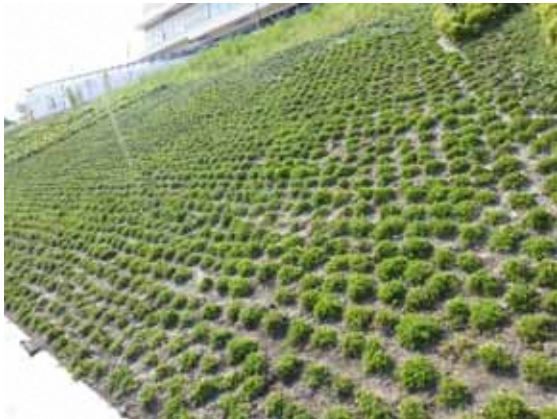
法面上部(遠景)
