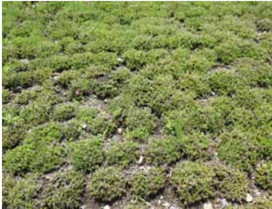
法面上部(近景)
