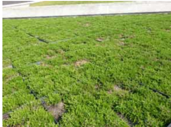
法面下部(遠景)
