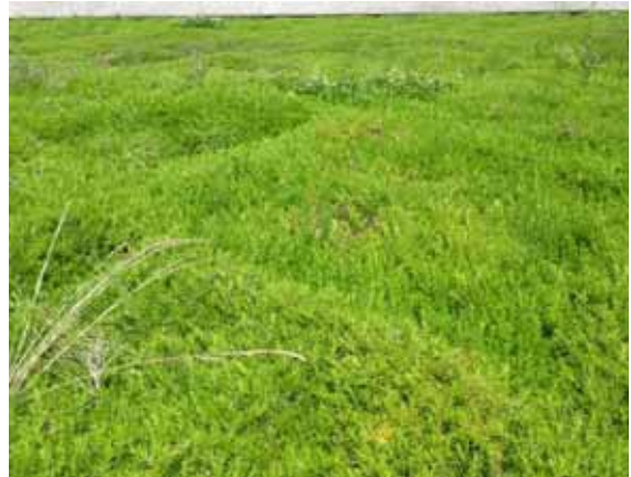
法面下部(近景)
