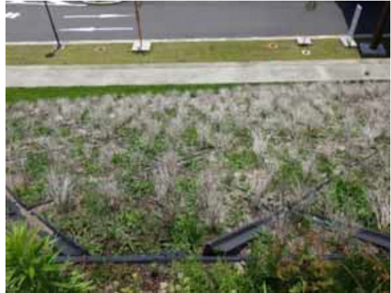
法面下部(遠景)
