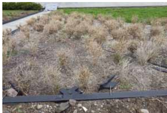
法面下部(近景)
