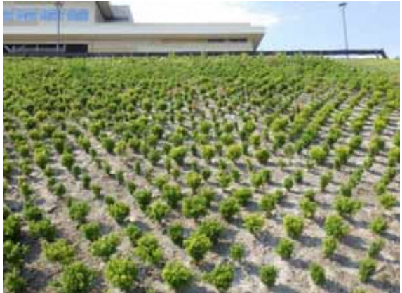
法面上部(遠景)
