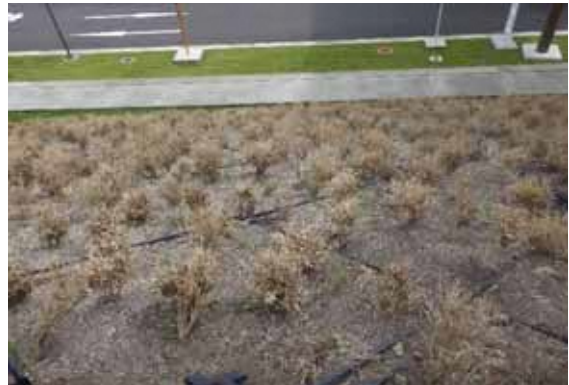
法面下部(遠景)
