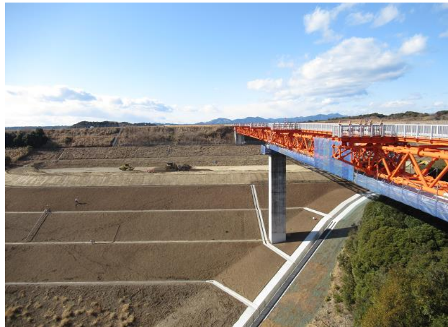
RESA整備工：上載盛土8段目施工中
