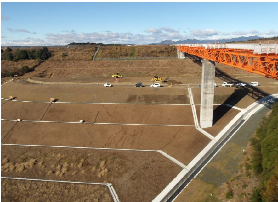
RESA整備工：上載盛土8段目施工中
