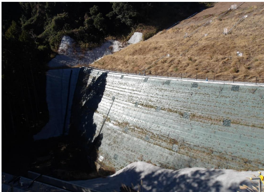
RESA整備工：上載盛土8段目施工中
