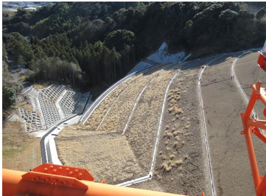
RESA整備工：上載盛土8段目施工中
