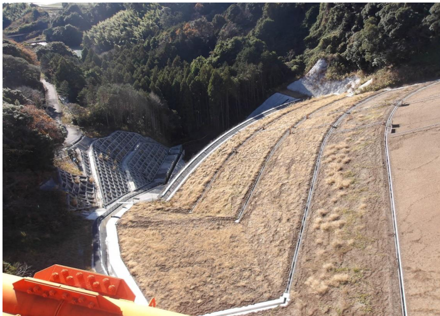
RESA整備工：上載盛土8段目施工中
