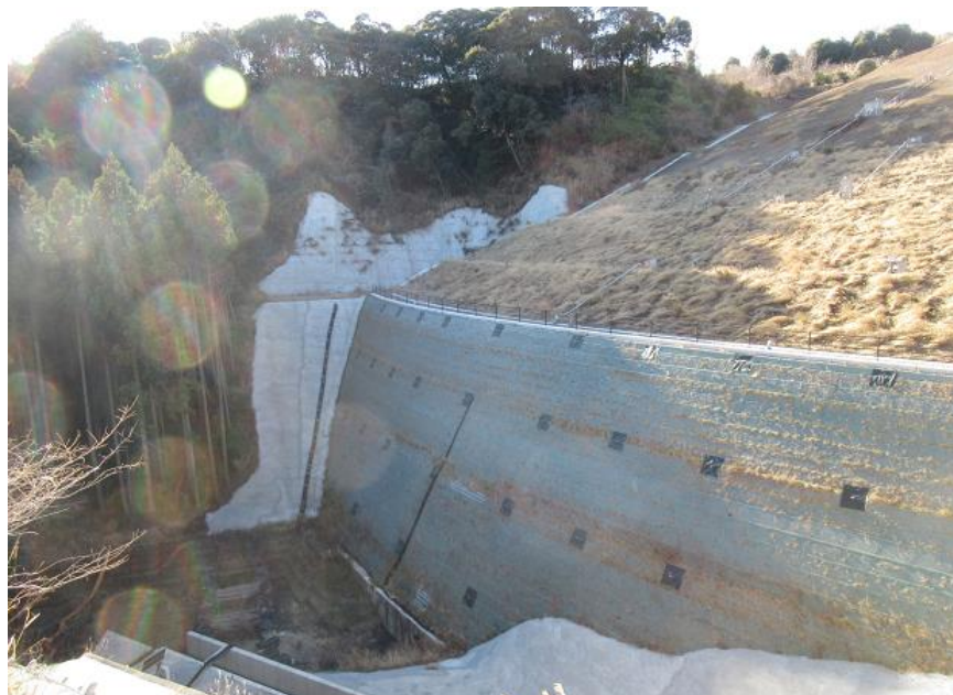
RESA整備工：上載盛土8段目施工中
