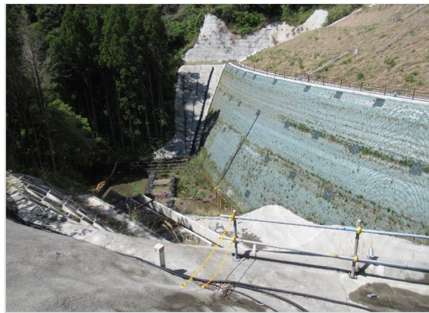
RESA整備工：上載盛土9段目施工中
