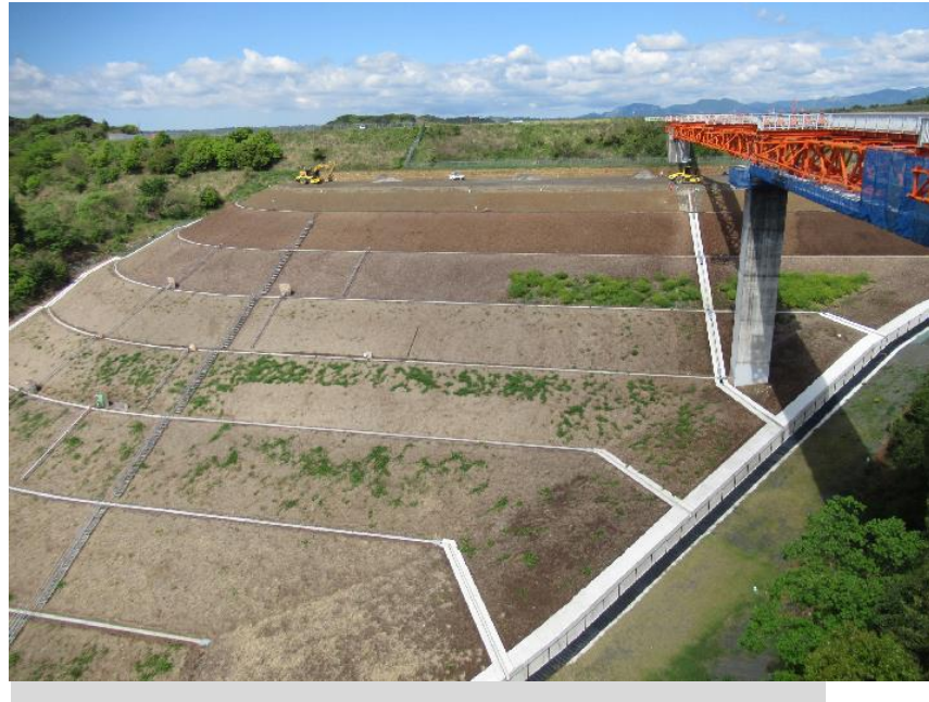
RESA整備工：上載盛土9段目施工中
