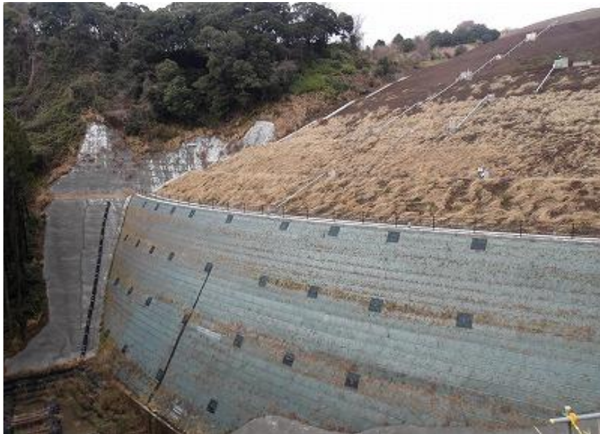
RESA整備工：上載盛土8段目施工中
