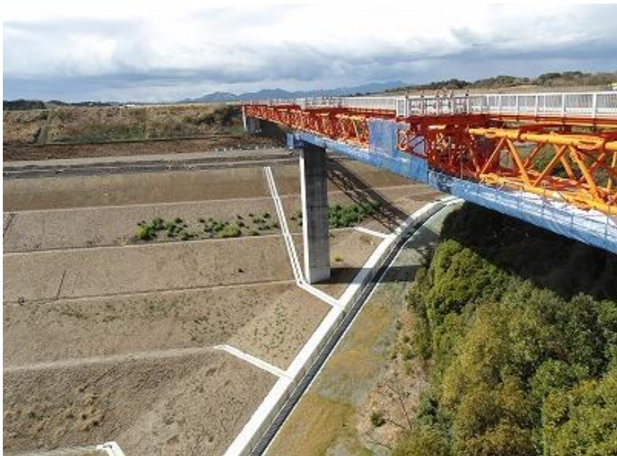
RESA整備工：上載盛土9段目施工中
