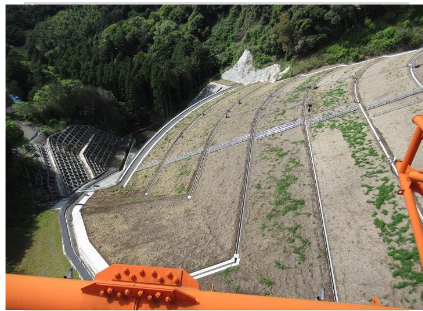
RESA整備工：上載盛土9段目施工中
