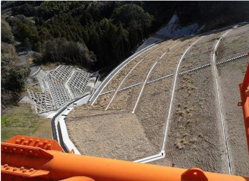
RESA整備工：上載盛土9段目施工中
