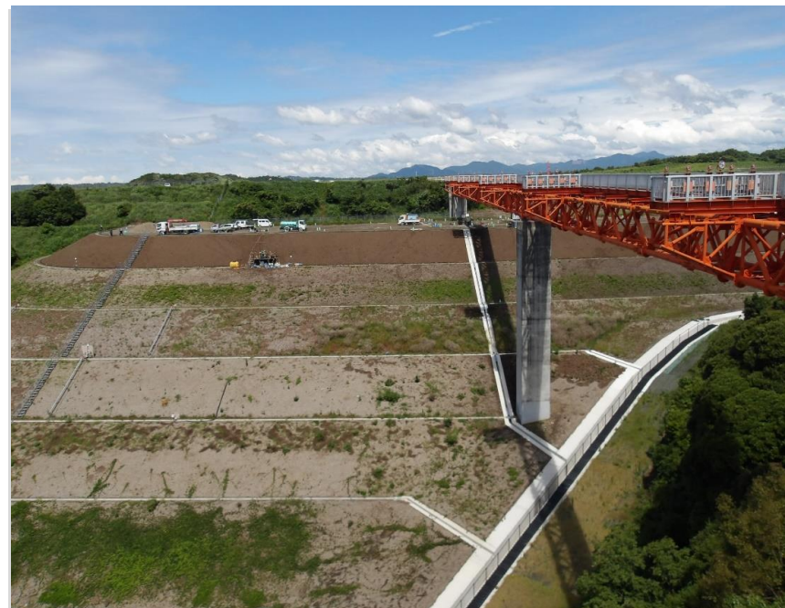
RESA整備工：A1橋台施工中
