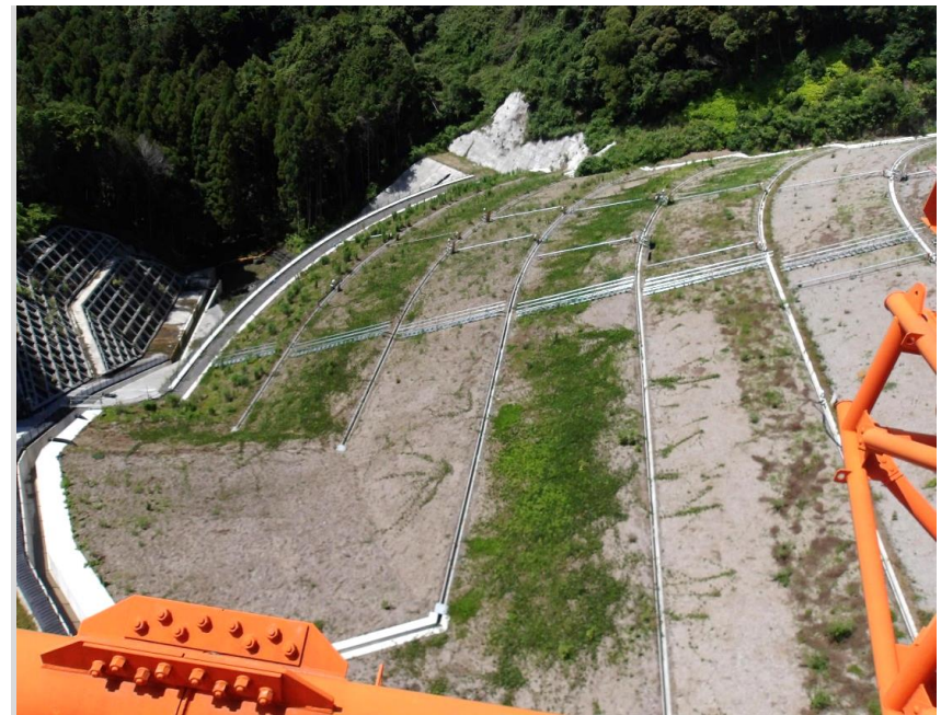
RESA整備工：A1橋台施工中
