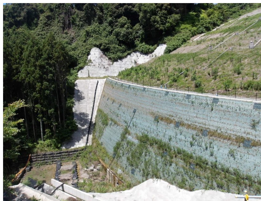
RESA整備工：A1橋台施工中
