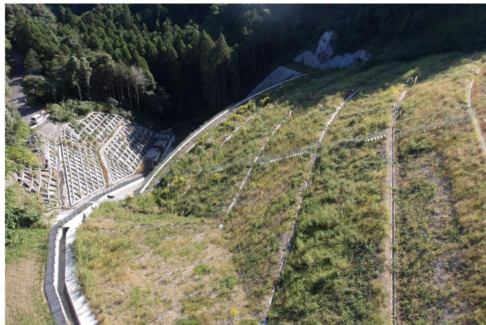
RESA整備工：橋梁上部工施工中
