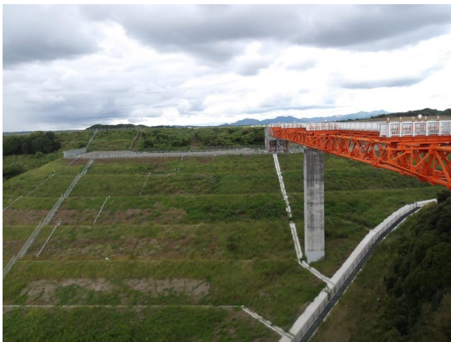
RESA整備工：橋梁上部工撤去中
