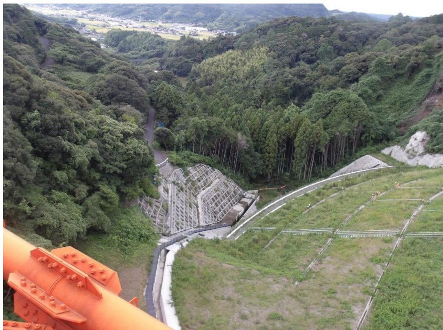
RESA整備工：橋梁上部工撤去中
