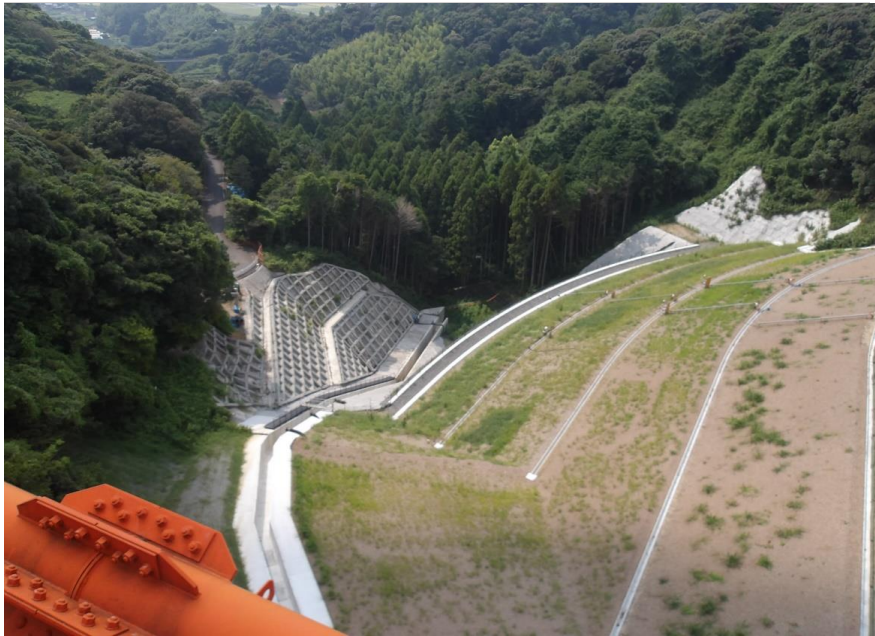
RESA整備工：上載盛土6段目施工中
