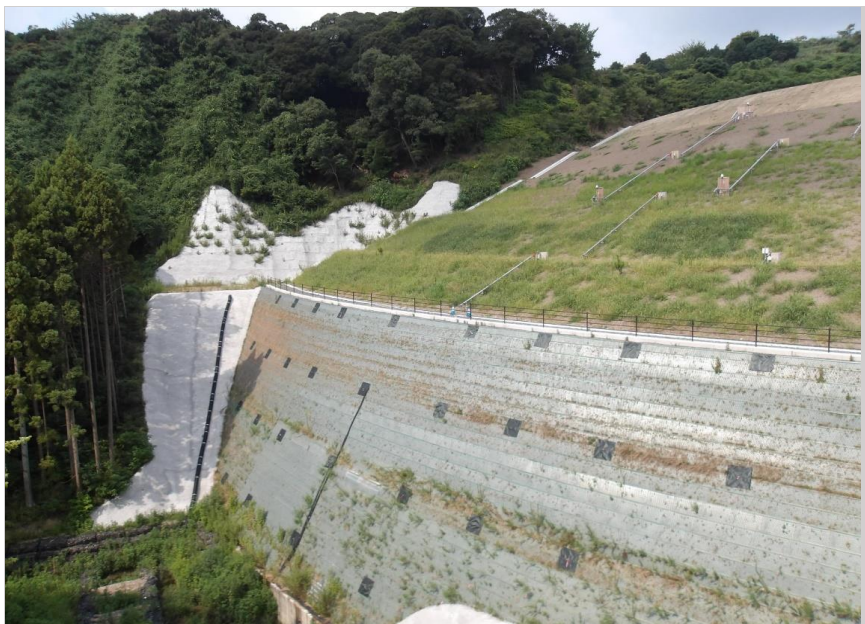
RESA整備工：上載盛土6段目施工中
