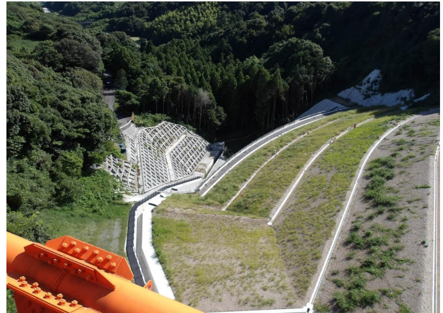
RESA整備工：上載盛土6段目施工中
