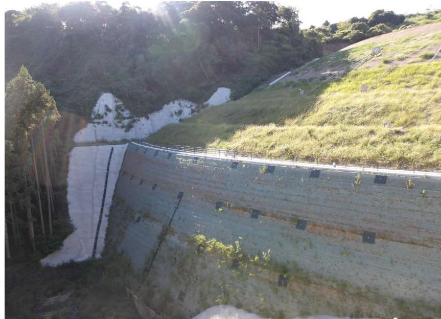
RESA整備工：上載盛土6段目施工中
