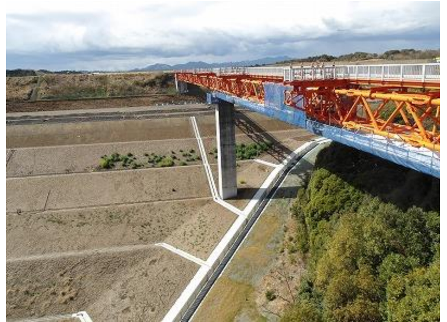
RESA整備工：上載盛土9段目施工中
