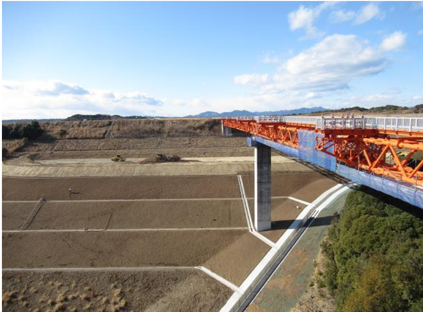
RESA整備工：上載盛土8段目施工中
