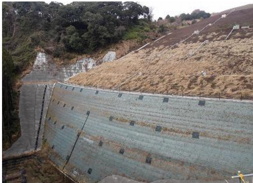
RESA整備工：上載盛土9段目施工中
