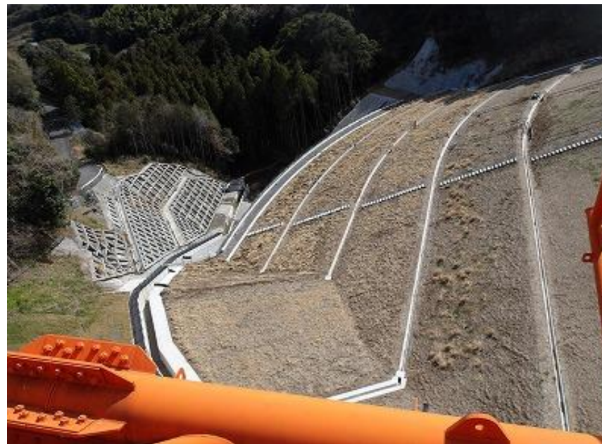
RESA整備工：上載盛土9段目施工中
