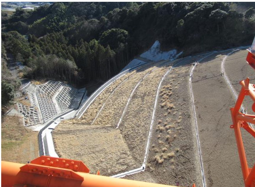
RESA整備工：上載盛土8段目施工中
