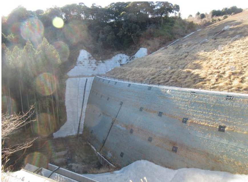
RESA整備工：上載盛土8段目施工中
