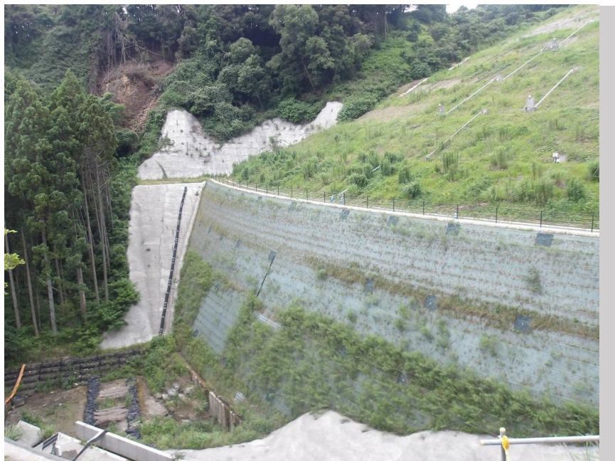
RESA整備工：A1橋台施工中
