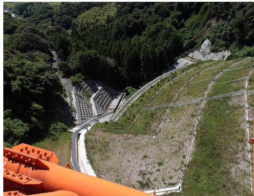
RESA整備工：橋梁上部撤去施工中
