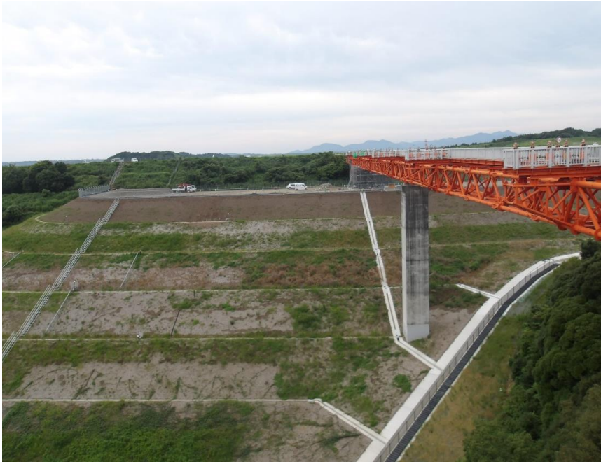
RESA整備工：A1橋台施工中
