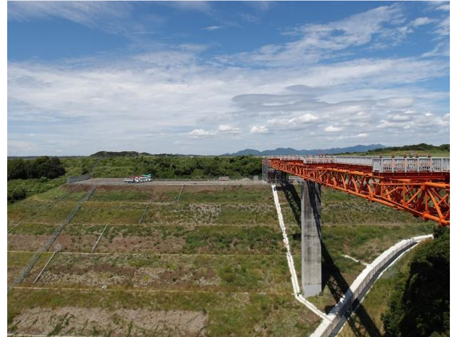
RESA整備工：橋梁上部撤去施工中
