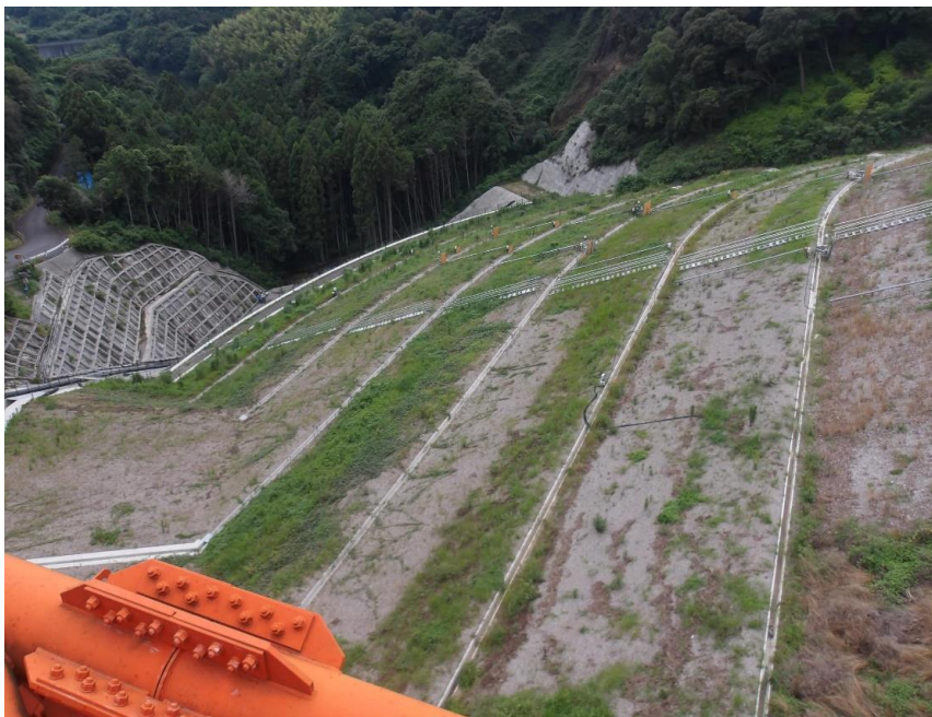
RESA整備工：A1橋台施工中
