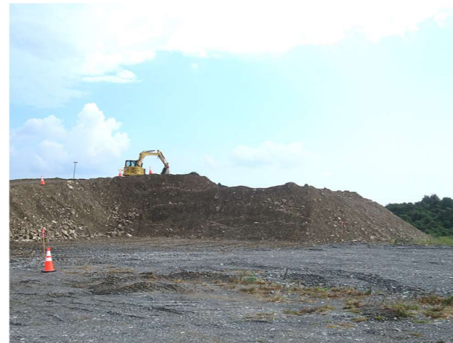
【整地工実施状況】
