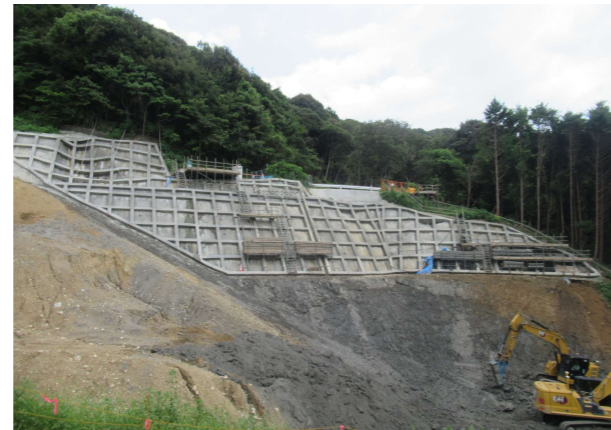
【法枠工進捗状況】
