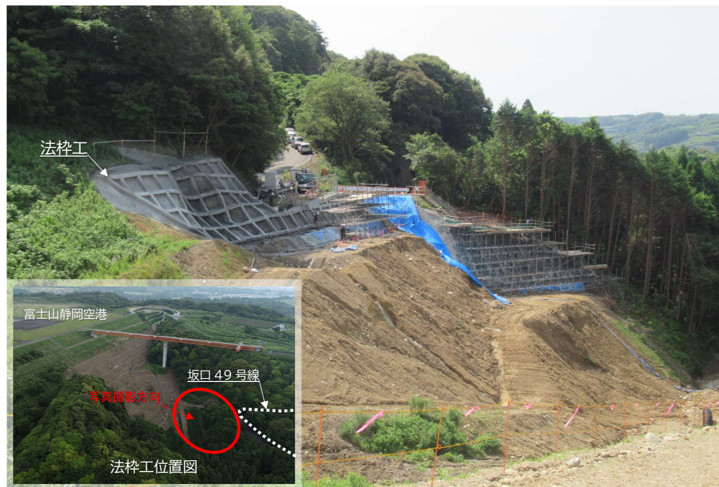
[法枠工実施状況]
