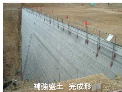
空港建設時の補強盛土工の施工の様子
