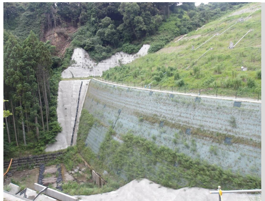
RESA整備工：A1橋台施工中
