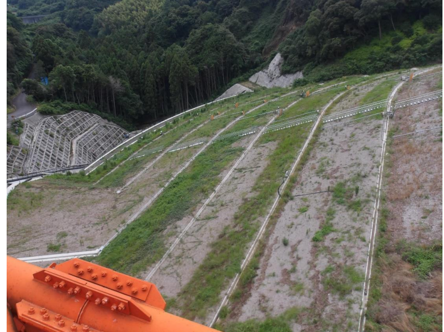
RESA整備工：A1橋台施工中
