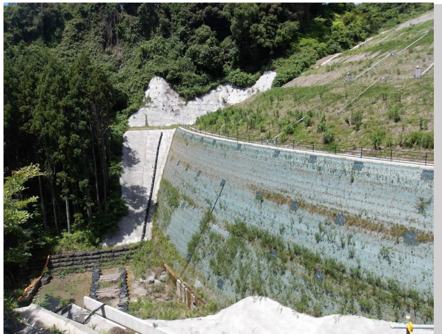
RESA整備工：A1橋台施工中
