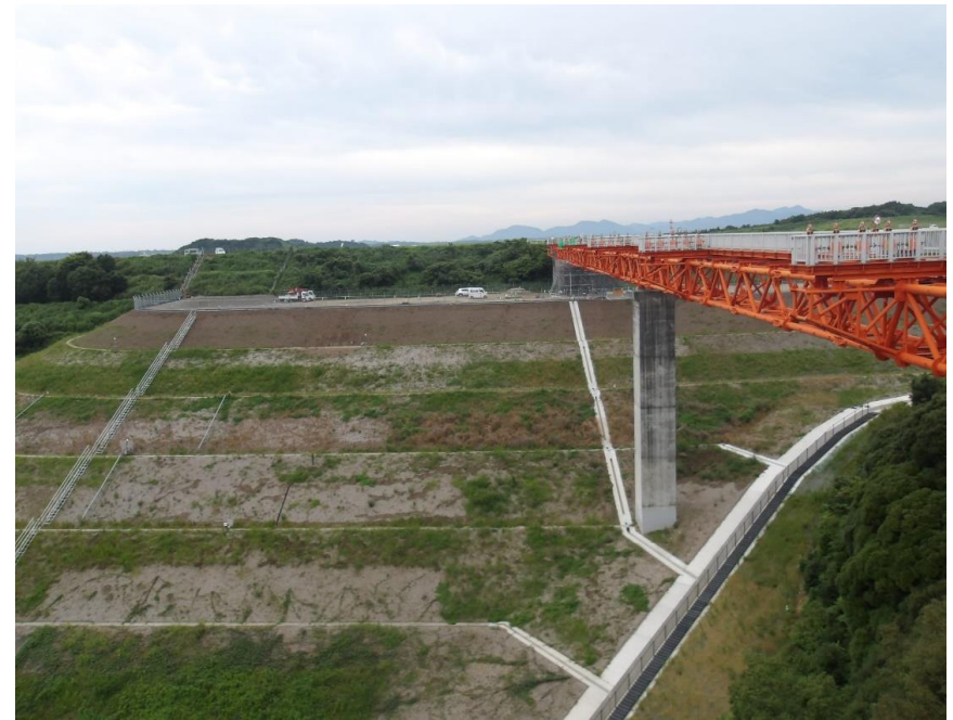
RESA整備工：A1橋台施工中
