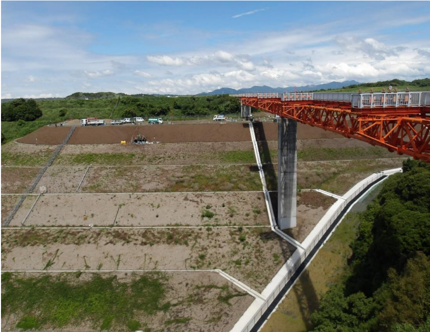
RESA整備工：A1橋台施工中
