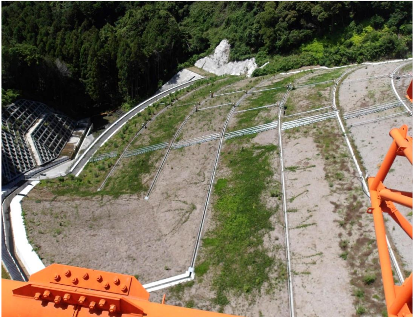
RESA整備工：A1橋台施工中
