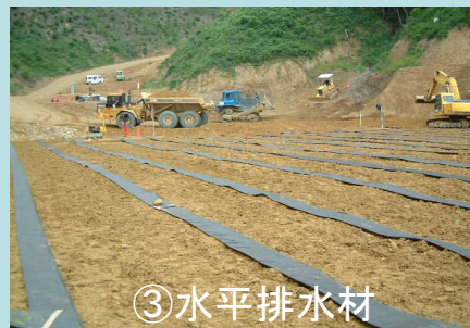
盛土内に浸入した水を排水
