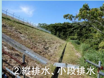
盛土内への水の浸入を防止
