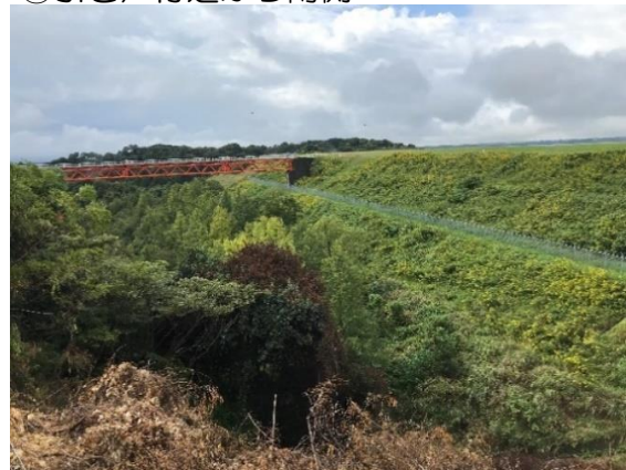
⑮ 引き戸付近から南側
