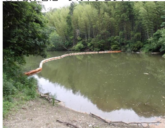
⑱千頭ヶ谷池 シルトフェンス
