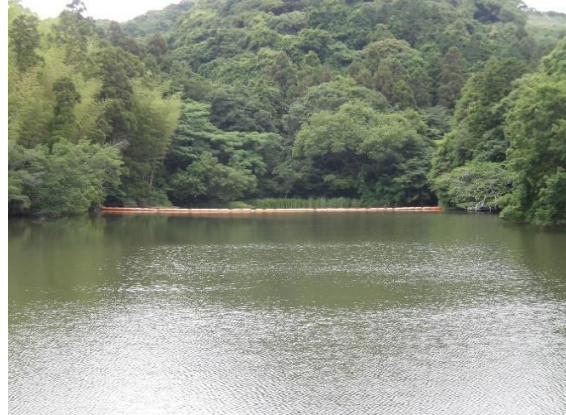
⑪千頭ヶ谷池 シルトフェンス
