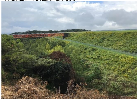
⑮ 引き戸付近から南側
