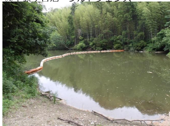
⑫千頭ヶ谷池 シルトフェンス
