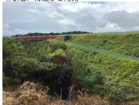
⑮ 引き戸付近から南側
