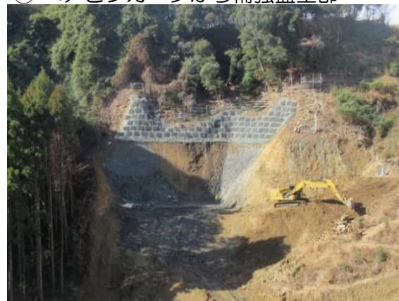
⑭ ヘアピンカーブから補強盛土部
