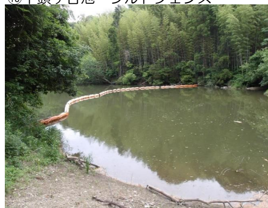
⑱千頭ヶ谷池 シルトフェンス
