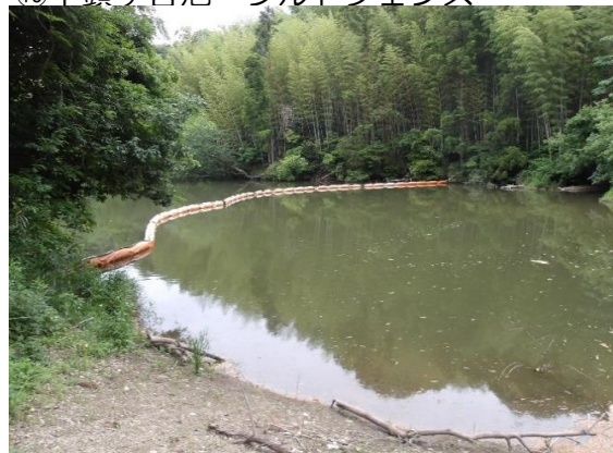
⑫千頭ヶ谷池 シルトフェンス
