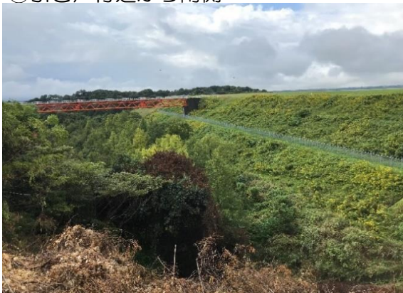
⑮ 引き戸付近から南側
