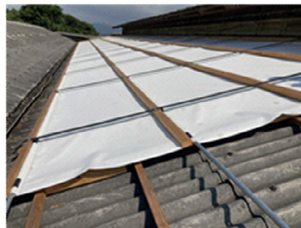
写真1 屋根に設置した放射冷却シート
