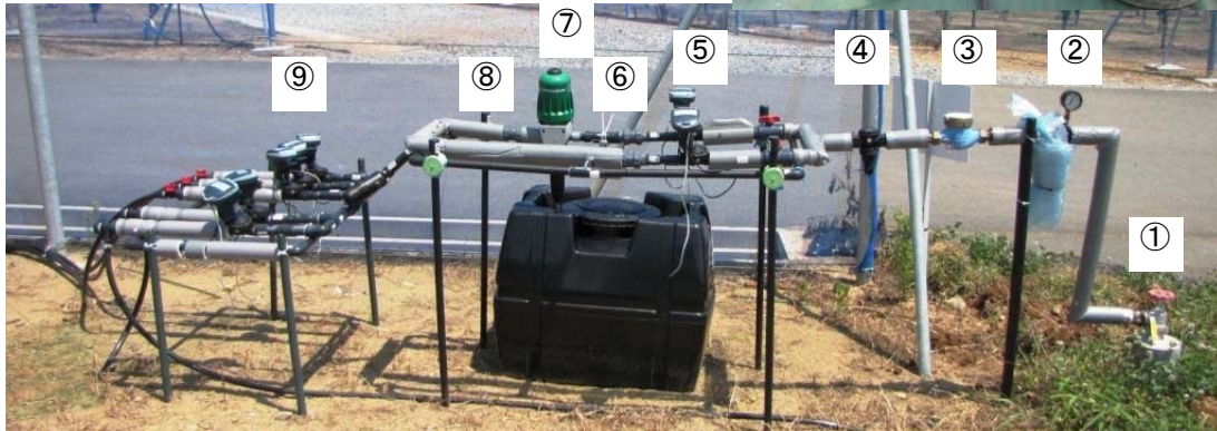
図1 自動液肥混入装置の設置例
