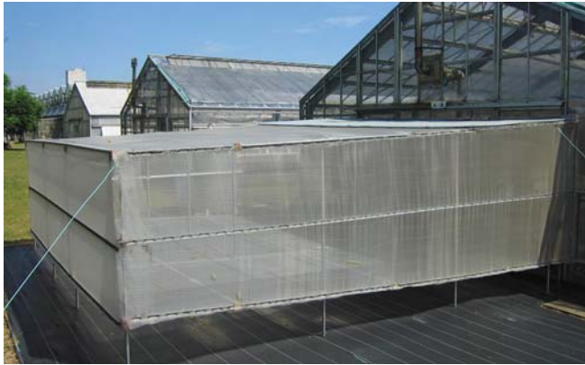
図1 陽圧式強制換気の設置事例 吸気部分に 0.4mm 目合いの防虫 ネットを設置して害虫の侵入を 防ぐ (写真は試作タイプ)。
