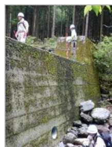
治山施設の点検
