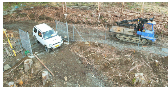
門扉を設置した金属柵
