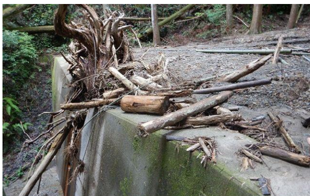
治山ダムの土砂・流木捕捉状況（浜松市天竜区大谷） 令和6年度県単治山事業により撤去
