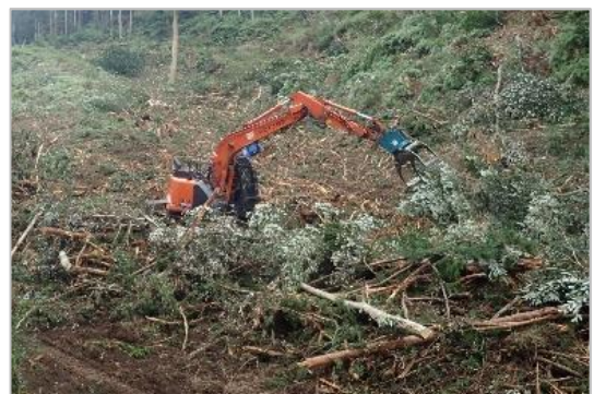
主伐箇所での機械地拵え作業(河津町)
