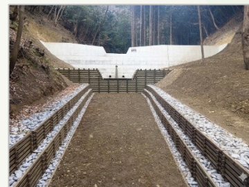
R7治山・林道コンクール 受賞箇所（松崎町雲見）
