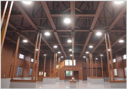
県産材を利用した施設 (掛川市:醤油醸造用倉庫)
