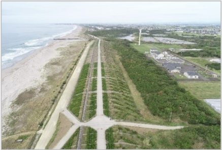
森の防潮堤(掛川市)
