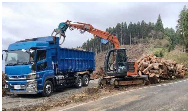
積込みの様子
