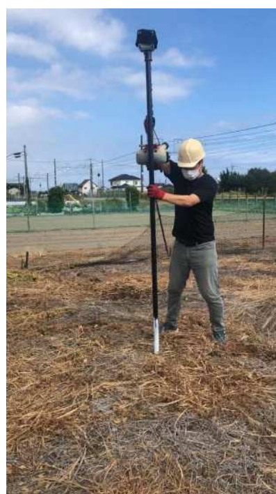
エンジン式杭打機（ビーバービックハンマー）
