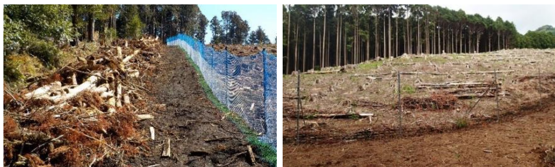
森林作業道脇に獣害防護柵を設置した事例
