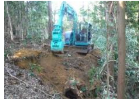
作業車道の開設
