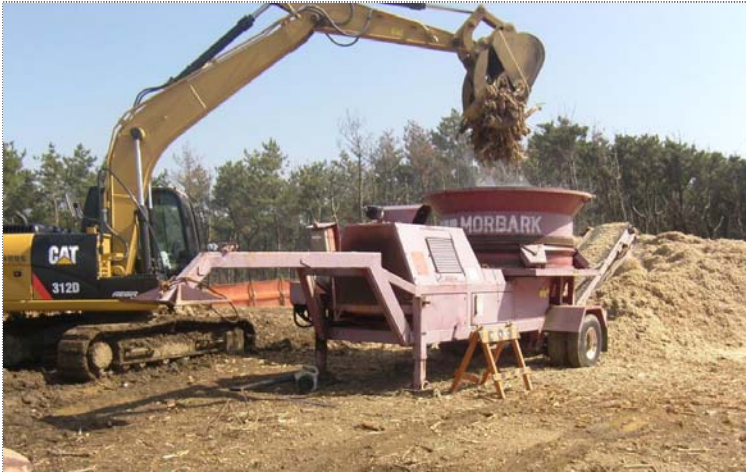
【現場内破碎状況】
