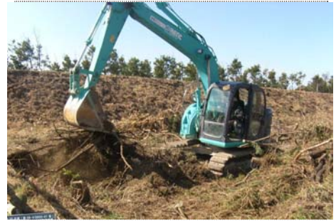
【伐採・除根状況】
