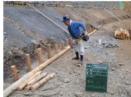
【施工状況】杭打ち
