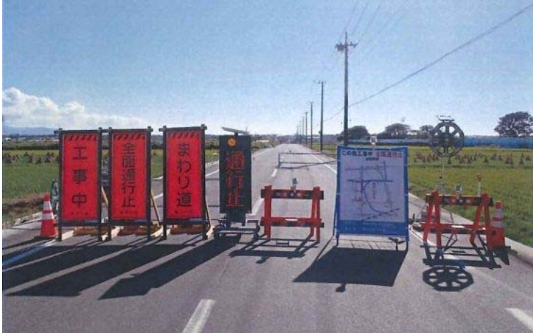
【写真】 設置状況
