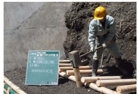
【施工状況】杭打
