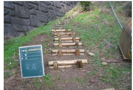
【巴川支杉谷津沢砂防堰堤本堤左岸側】
