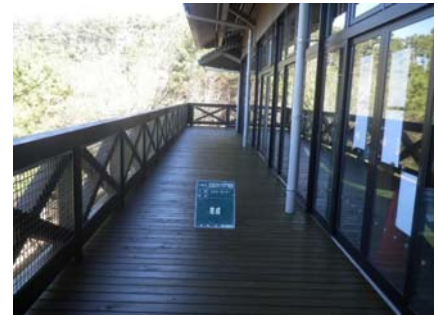
【テラス床板の更新】
