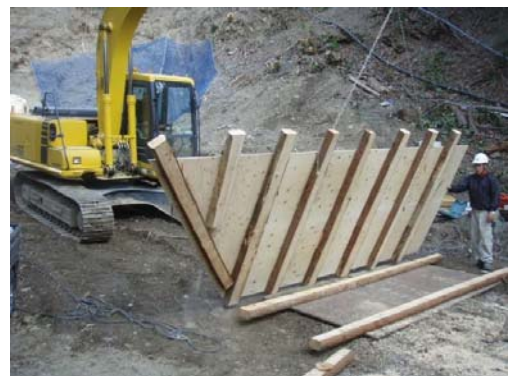
【外側からみた状況】太鼓材(t=9cm)を合板型枠に固定
