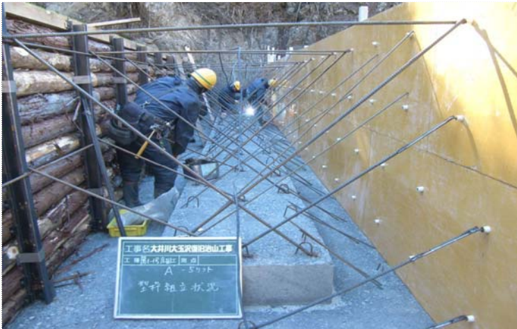
【施工状況 合板型枠(県産材100%(下流))、残存型枠(上流)】
