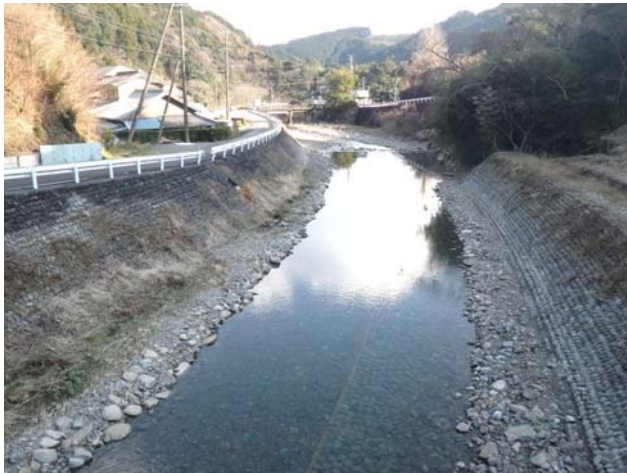
【完成写真(水位復旧後)】
