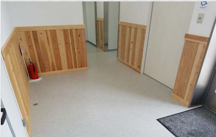
【内壁の内装材として県産材の腰壁を活用(1階エントランス)】
