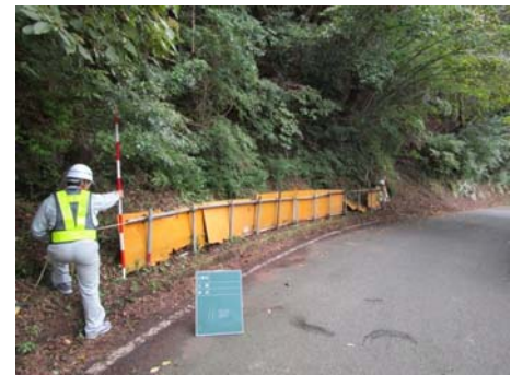
【(参考)撤去した既設の柵 (鋼製パイプ及び合板製)】
