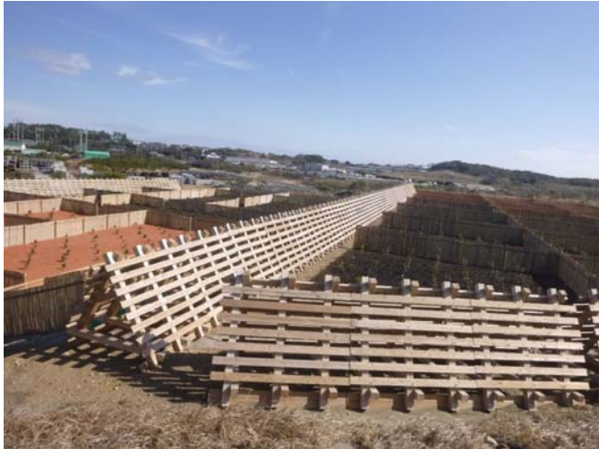
【施工完了】防風工
