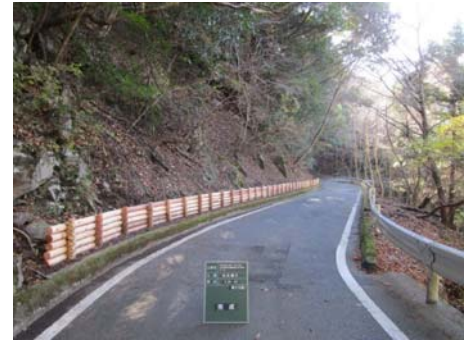
【木柵工 設置状況】
