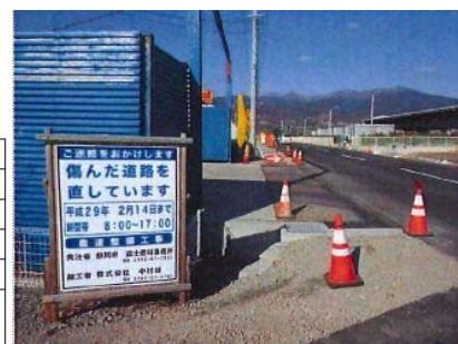
【設置状況②】
