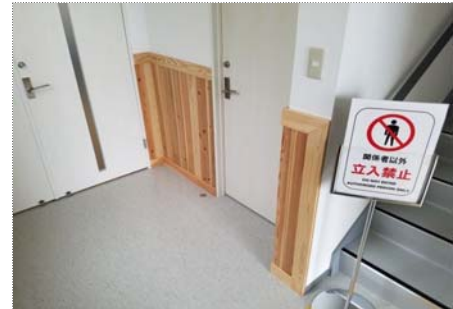
【内壁の内装材として県産材の腰壁を活用】
