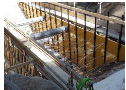
【型枠完成時(上流側)】合板・平割材残存
