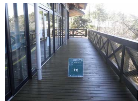
【テラス床板の更新】
