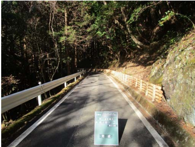
【木柵工 設置状況】
