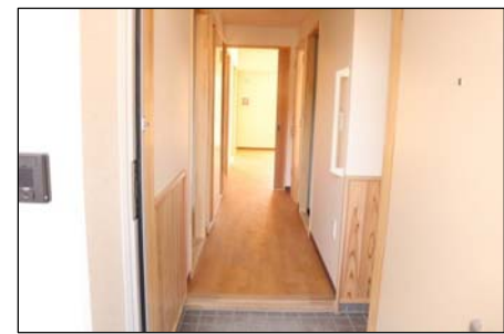
【玄関】腰壁部県産杉板
