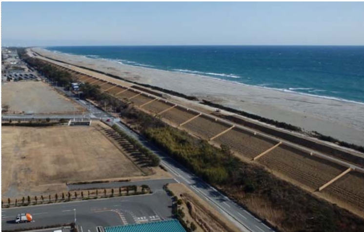
【静砂工設置状況】
