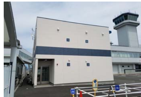
【第2東別棟外観】
