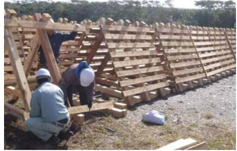
【施工状況】防風工組立
