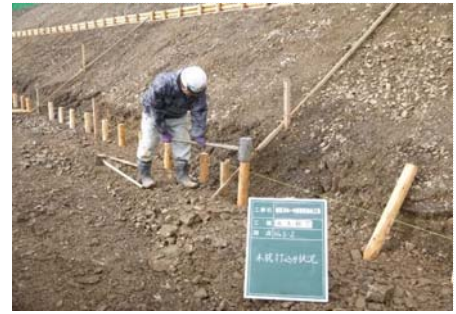
【施工状況(木杭打込)】
