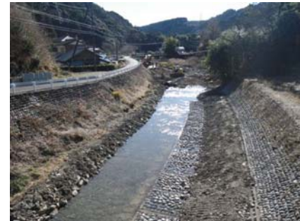
【施工完了(水位復旧前)】
