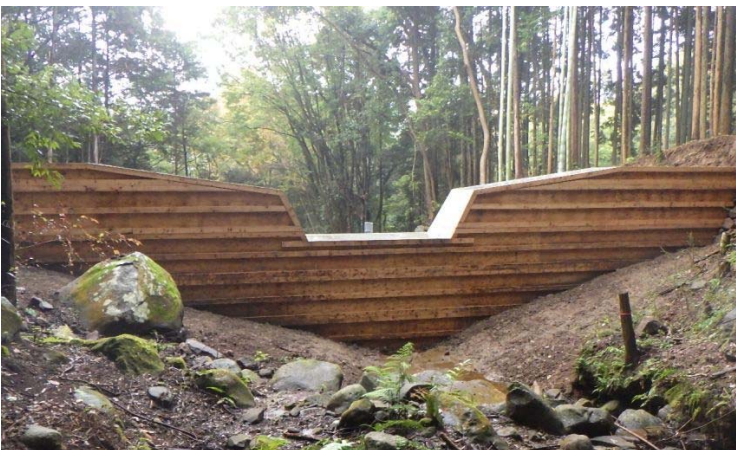
【カチオンフレーム工法(県産材合板仕様) 谷止工完成時】
