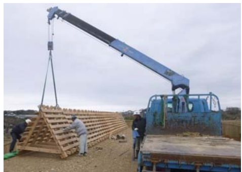
【施工状況】防風工据付
