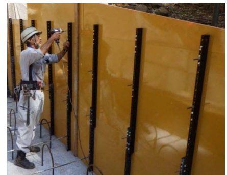
【施工状況】カチオンフレーム組立
