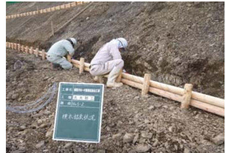
【施工状況(横木結束)】
