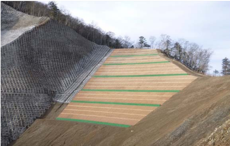
【施工完了状況】
