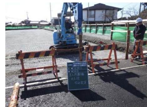
【丸太杭打込状況】
