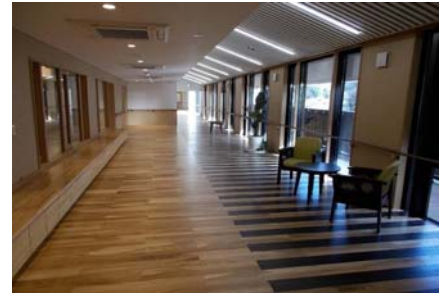
【A棟いずのえんがわ 床ナラ合板フローリング】
