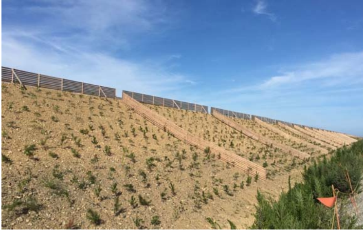
【静砂工設置状況】
