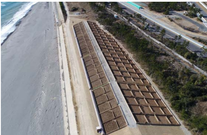
【設置状況(全景)】
