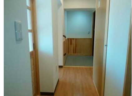
【玄関】 腰壁スギ縁甲板張り
