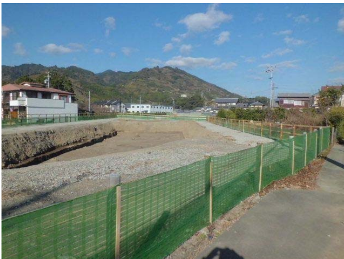
【立入防止柵設置完了(安全ネット有)】
