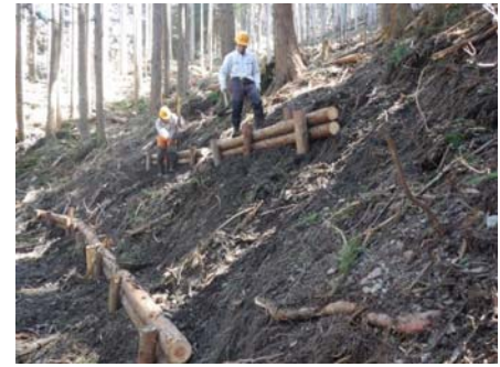
【施工中】人力による簡易な施工
