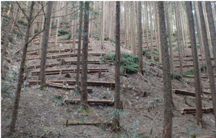
【現地発生材を利用した簡易木製土留を設置】
