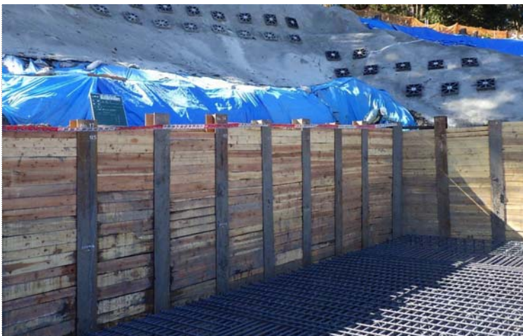
【山留工設置状況】
