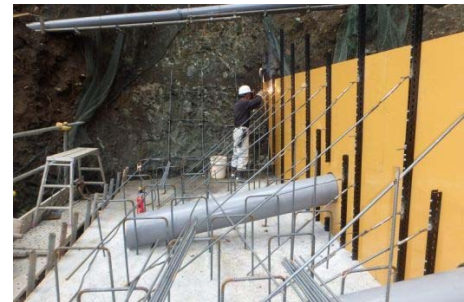
【施工状況】セパボルト溶接
