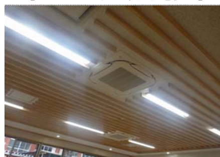
【天井の木製格子に県産材を使用】
