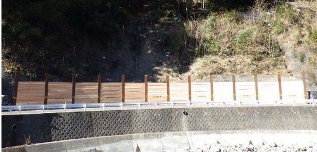
【写真】 仮設防護柵設置
