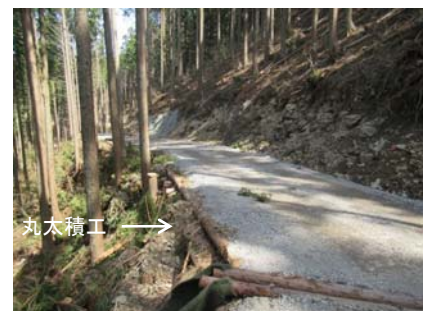
【丸太積工を施工した作業道】
