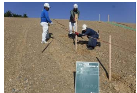
【施工状況(杭打ち込み)】
