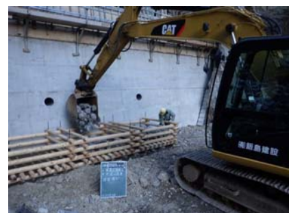
【施工状況】詰石作業
