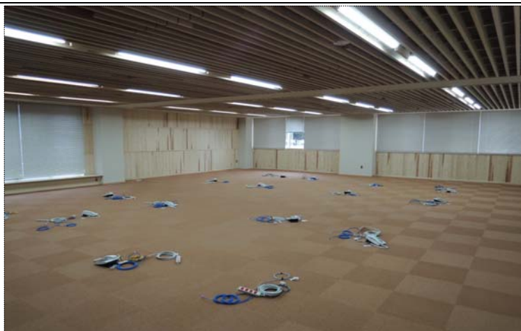
【1階各班室 天井木ルーバー、壁面羽目板仕上】
