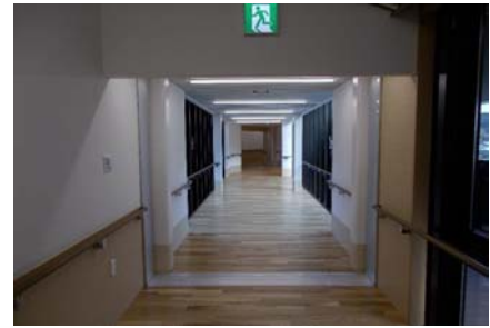
【B棟2階 腰壁すざ板県産材】
