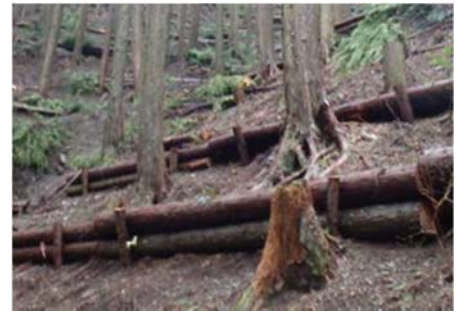
【丸太を2本積み、杭木打設により固定】
