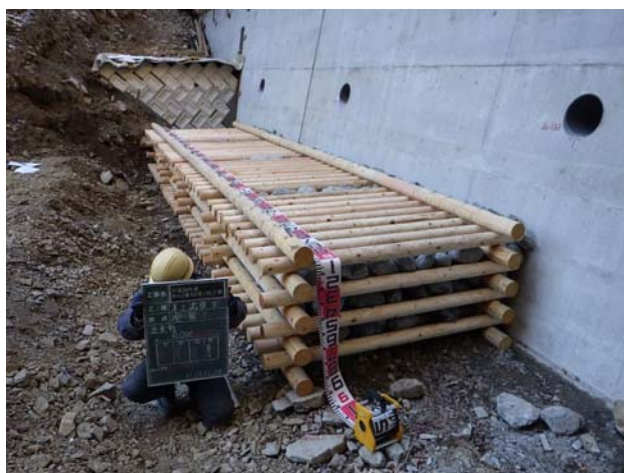
【木工沈床】杉丸太を組み合わせ、内部に詰石を行う
