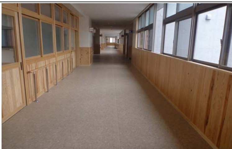
【内壁の内装材として県産材の腰壁を使用】
