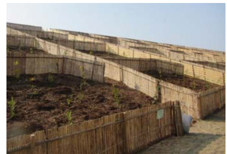
【設置状況(近景)】
