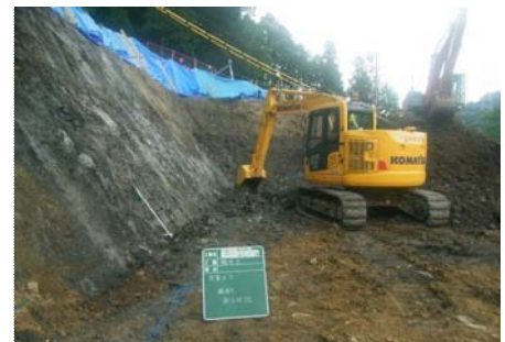
【掘削状況(山留工設置前)】
