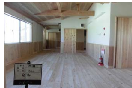
【構造材に県産材を、柱には杉材を用いた】
