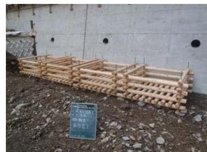
【施工状況】杉丸太組立
