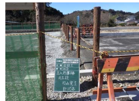
【丸太杭打込完了】
