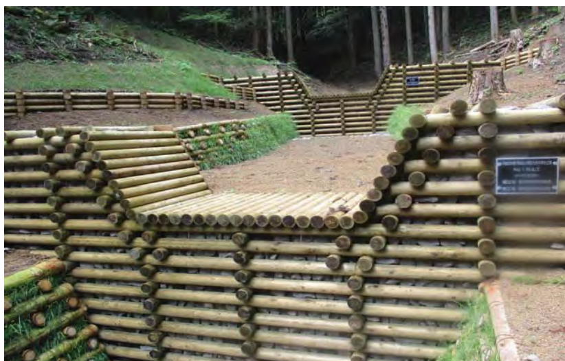
【木製治山ダム完成時】
