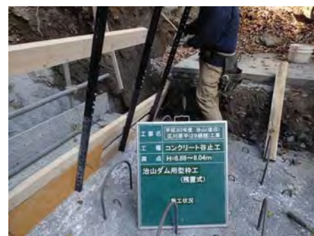
【施工状況 上流側 型枠組立①】
