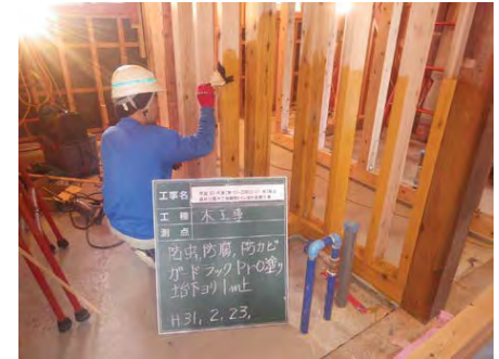
【間仕切壁下地施工状況】
