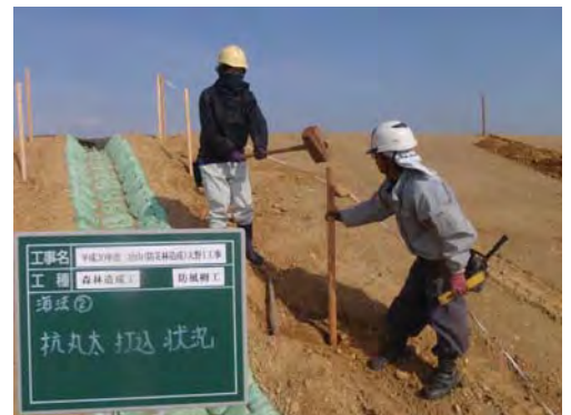
【杭打込みの状況】
