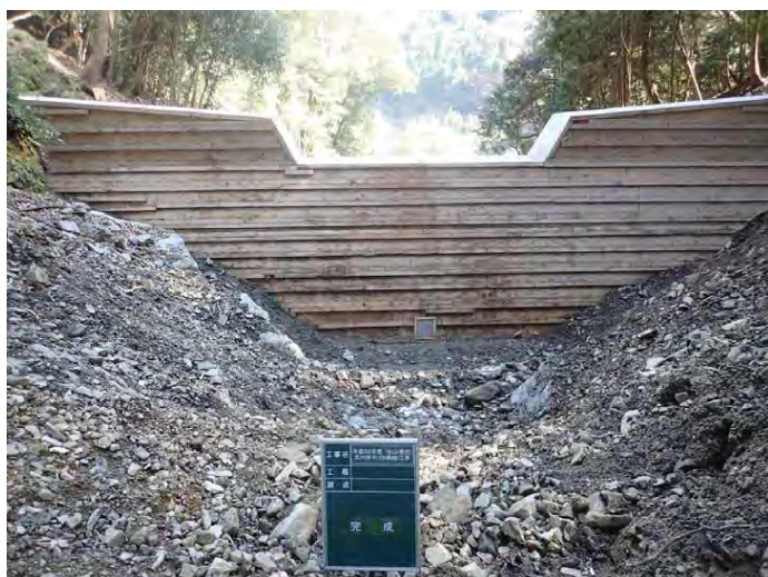
【谷止工上流側の残存型枠の状況】
