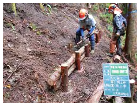
【施工中 人力による簡易な施工】
