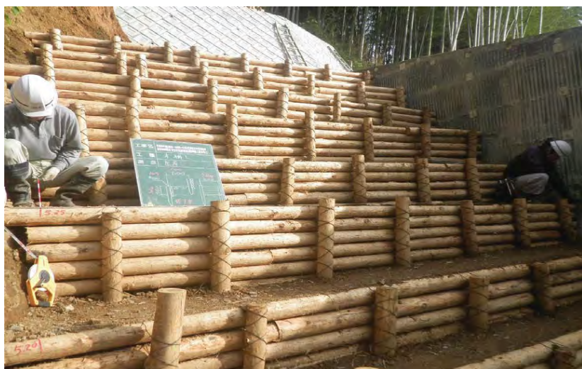
【砂防堰堤間詰として使用した木柵工】
