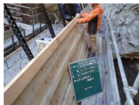
【施工状況 上流側 型枠組立②】
