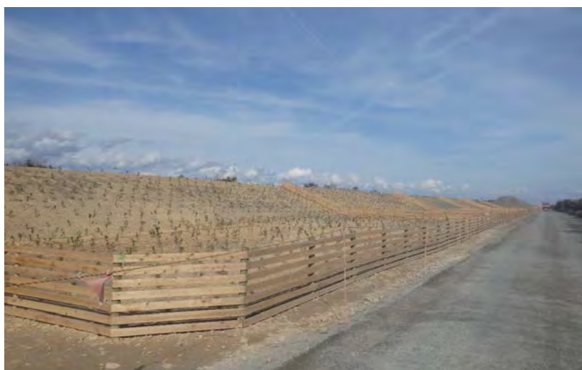
【静砂工設置状況】
