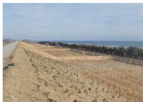
【遠景(防潮堤天端より)】
