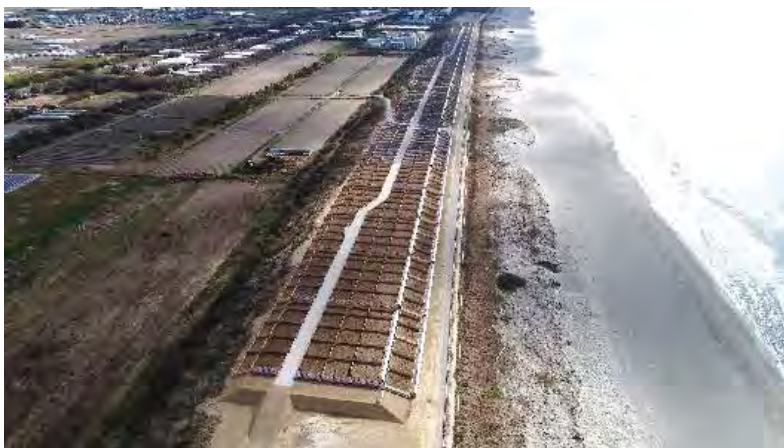
【設置状況(全景)】
