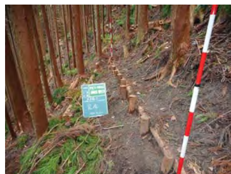
【完成 現地発生材利用によるコスト縮減】
