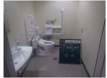
【多目的トイレ設置完了状況】
