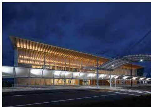
【ライトアップした西側増築部】
