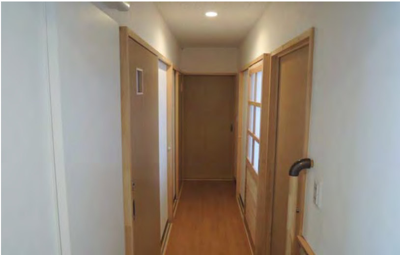
【廊下(建具、枠、腰壁等に県産材を使用)】
