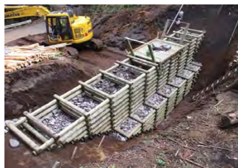
【施工状況 丸太組立て】
