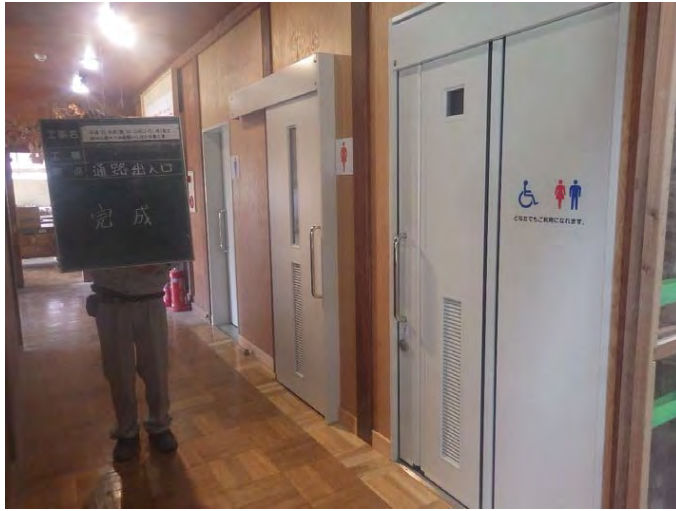
【トイレ改修完了状況】
