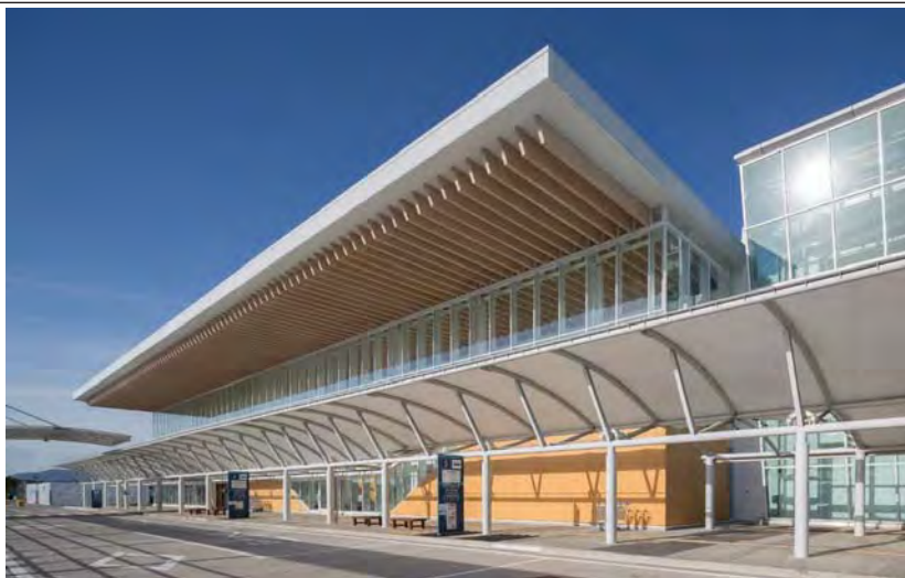
【西側増築部の外観(庇のある平屋根に県産材を活用)】
