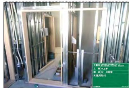
【休憩室建具枠は県産材檜を使用】
