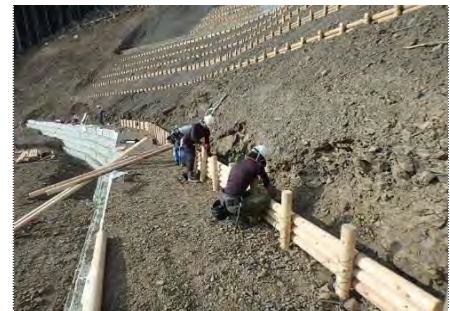
【背丸太設置・緊結作業の状況】
