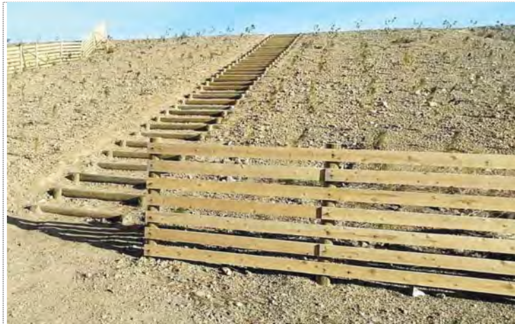
【静砂工・丸太階段工設置状況】
