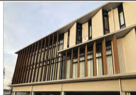
【ルーバー(校舎西側)】
