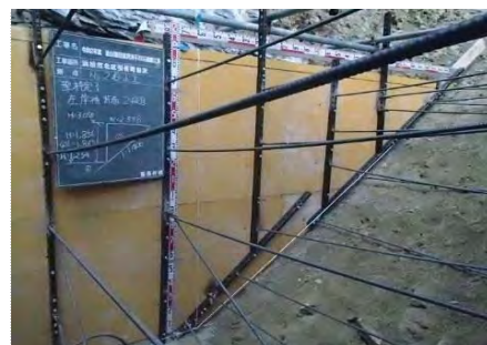
【施工状況】 合板型枠設置状況
