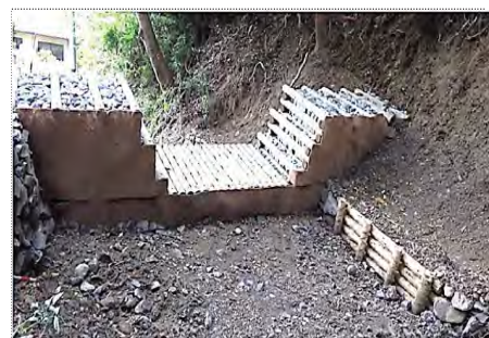
【木製校倉式床固工(背面)】
