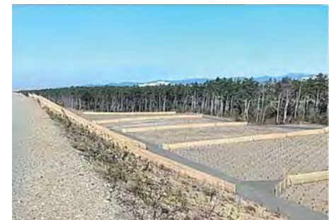
【遠景】(防潮堤天端より)
