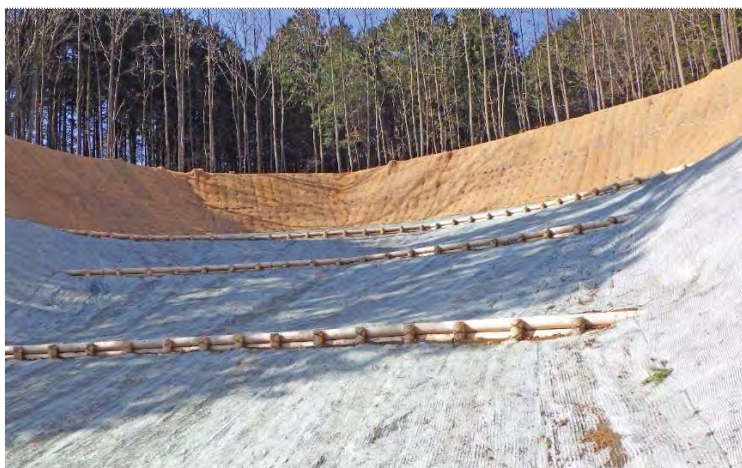
【丸太筋工(3本筋工)】
