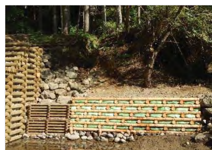
【左岸: 木製枠(国産材)、丸太積間詰】
