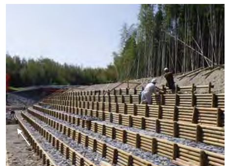
【木柵護岸施工状況】
