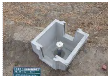
【堰板用の溝がある給水柵】
