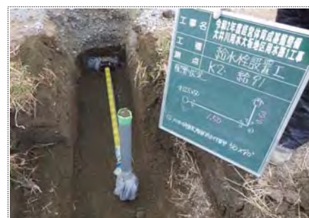
【給水管 布設状況】
