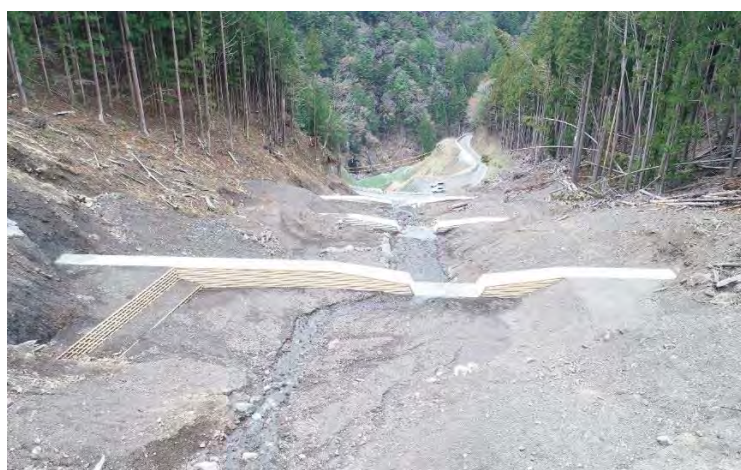
【谷止工完成】谷止工背面の状況
