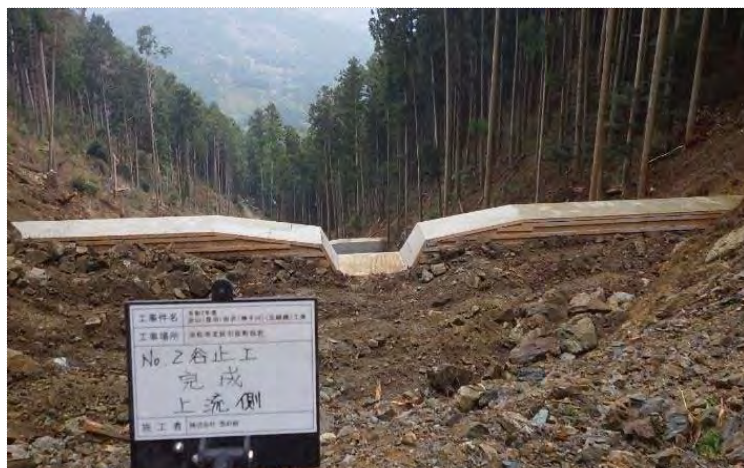
【谷止工完成】 谷止工背面の状況
