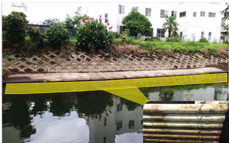
【木柵護岸工 完成】
