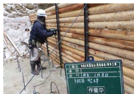
【施工状況】型枠の設置
