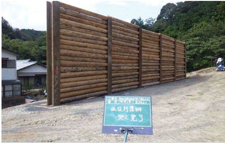
【仮設防護柵工 (全長L=15m)】
