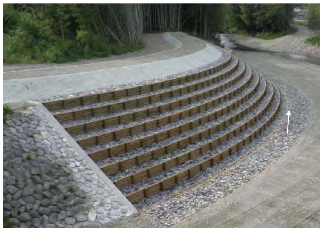
【木柵護岸工設置状況】
