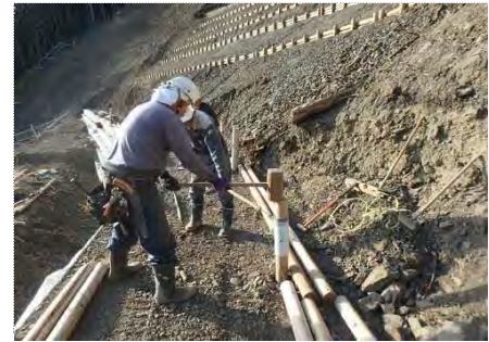
【人力杭打ち作業の状況】
