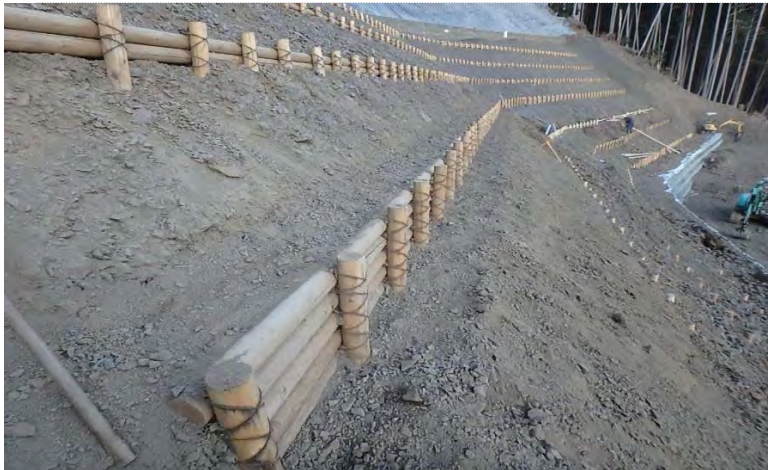
【崩壊地において横からみた丸太柵工】
