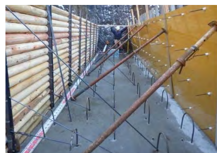
【施工状況】型枠設置完了
