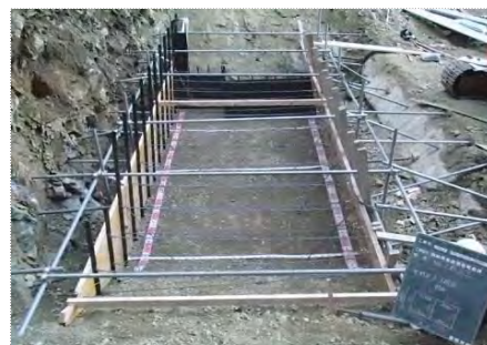
【施工状況】 合板型枠設置状況
