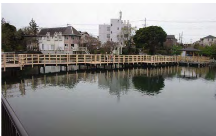
【丸池連絡橋全景(晴天時には逆さ富士も望める)】
