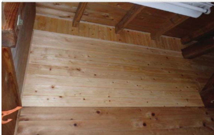
【内部間仕切り 完成】
