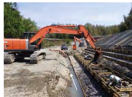
【木工沈床施工状況】
