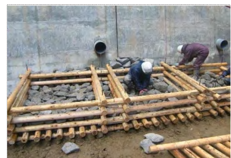
【施工状況】 詰石の敷並べ
