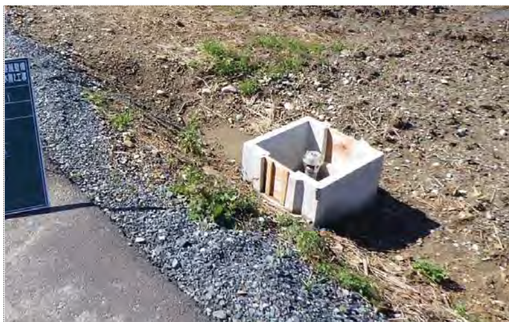
【県産材で製作された堰板の使用状況】
