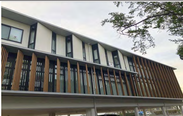
【ルーバー(校舎東側)】
