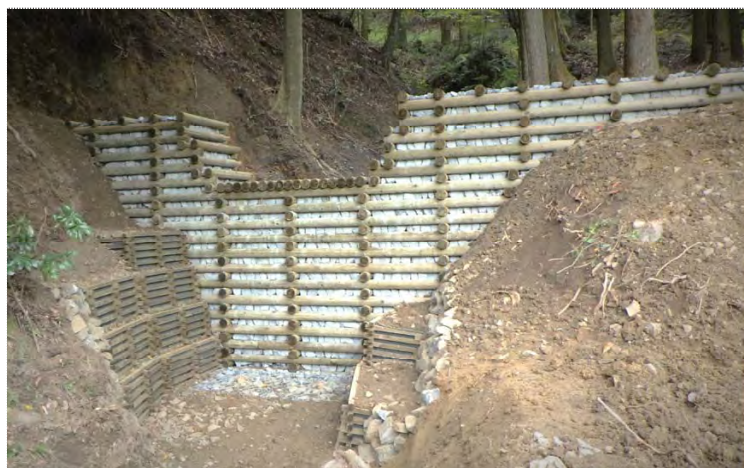
【木製校倉式床固工(正面)】
