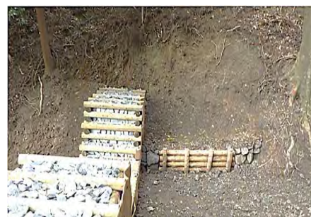
【木製校倉式床固工(右岸)】
