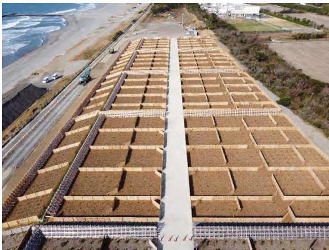
【設置状況(全景)】
