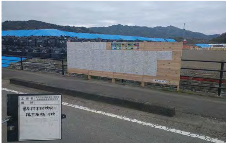
【工事案内看板】
