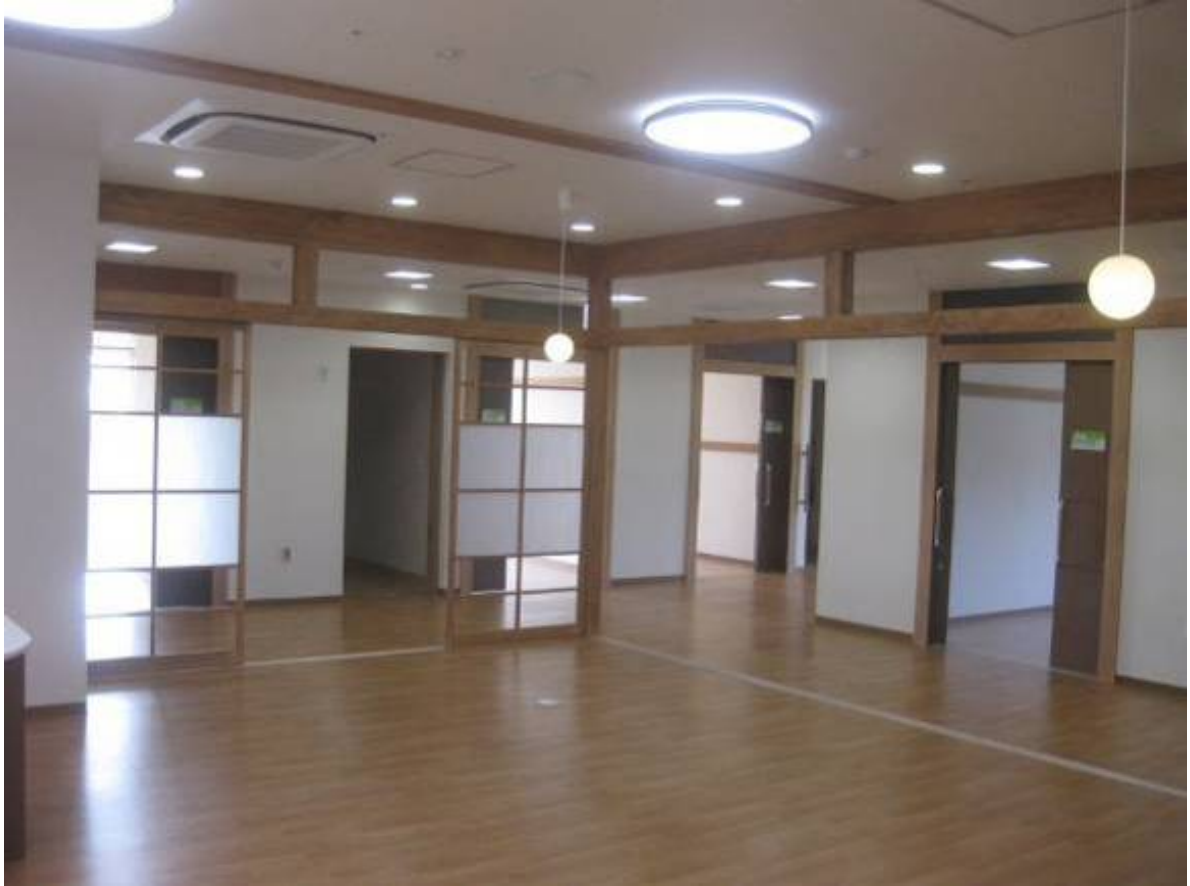
【各ユニット 共同生活室】柱や梁、造作材に使用
