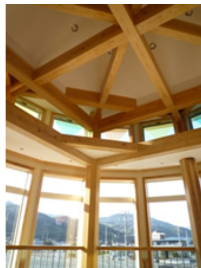
【現しとなっている小屋組み】
