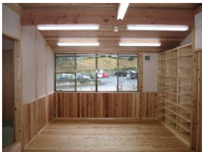
【内装】壁、床、天井を木質化
