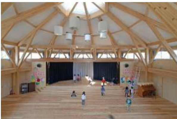
【遊戯室】トラス構造の見える壁面
