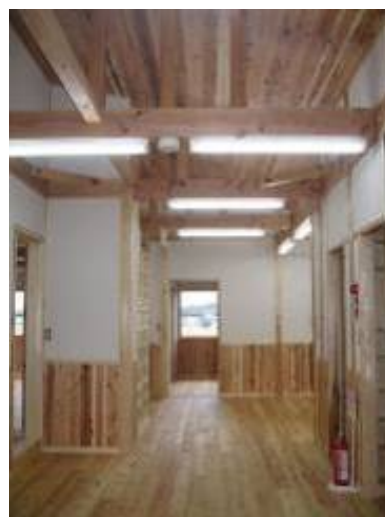
【内装】梁や柱も見せている
