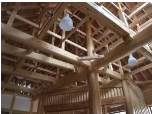
【玄関付近】 柱や梁を見せる造り
