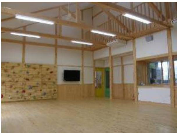
【遊戯室】 梁を現し、床もヒノキを使用
