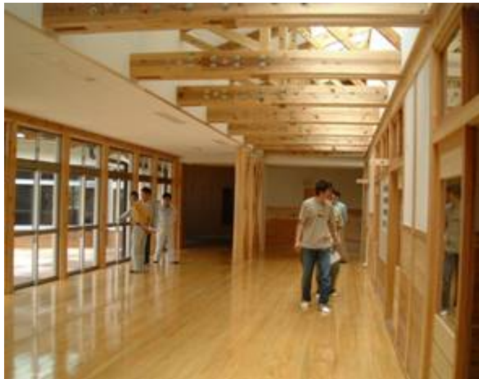
【内装】構造材、床などの内装材に県産材を使用
