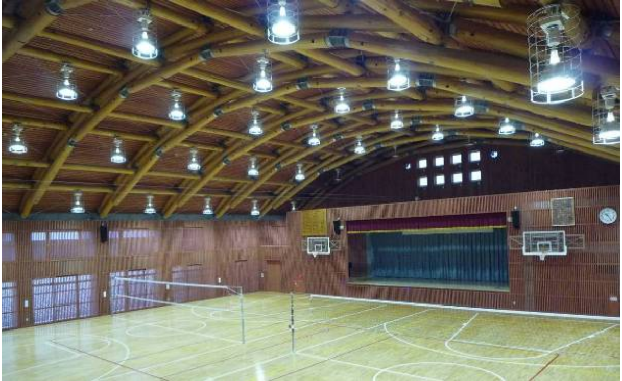
【全景】体育館内部 スケルトンログ構法の天井が見える
