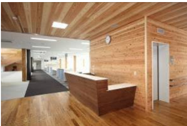
【内装】床は圧密フローリングを採用
