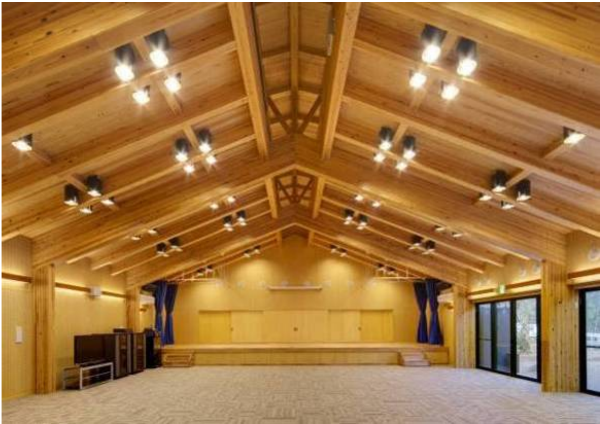
【大広間】 県産材を加工した大断面集成材を主構造に使用
