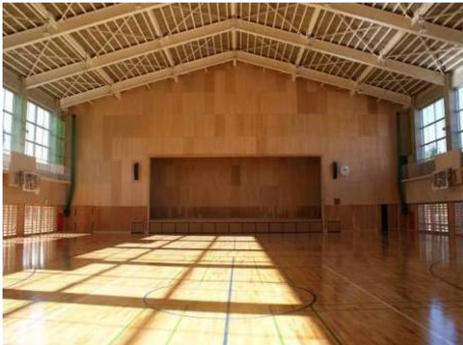
【体育館】壁面の内装材
