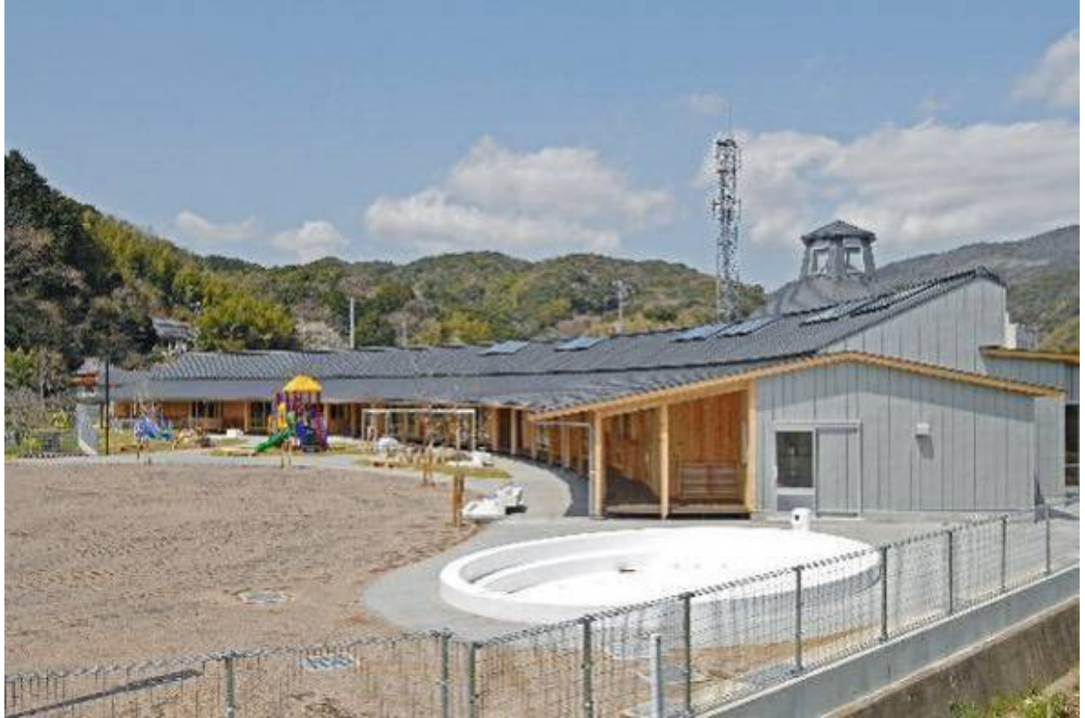
【外観】東側道路から園庭、園舎を望む
