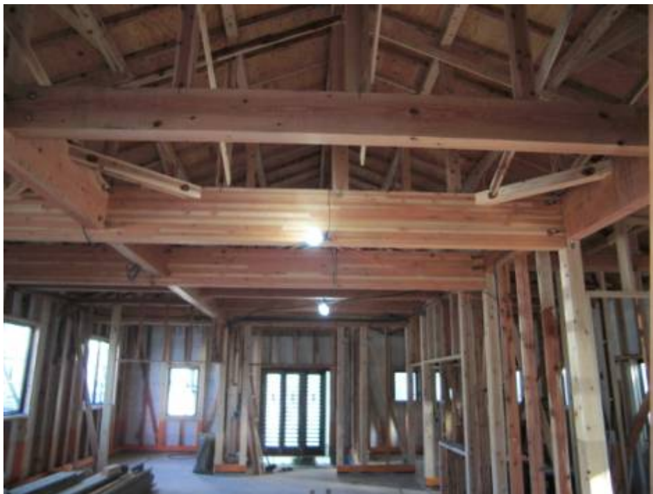
【建設中の内部の様子】 構造材にヒノキ、スギを使用
