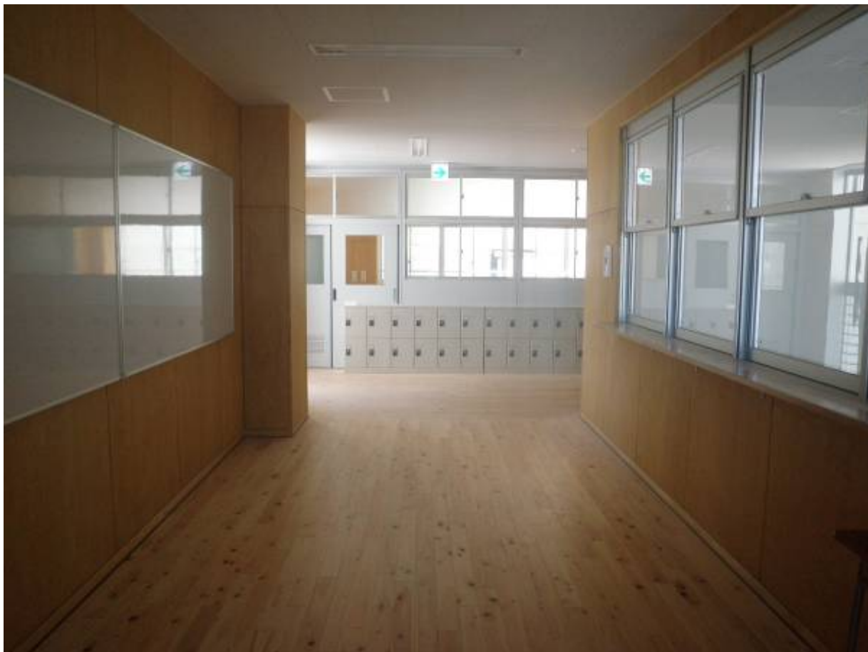
【廊下】壁に県産材合板、床にヒノキのフローリングを採用
