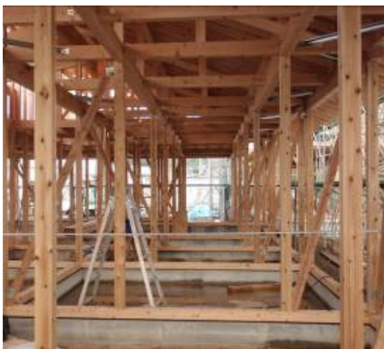
【建築中の内部の様子】
