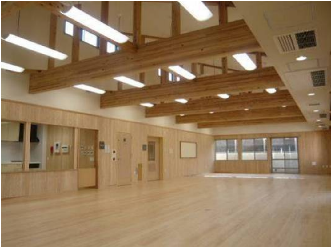
室内に露出させた梁等の小屋組みが存在感をあらわしている
