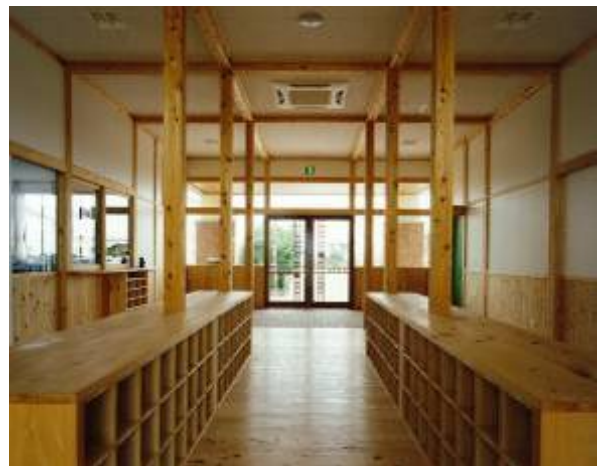
【玄関ホール】 柱、壁に節のあるヒノキを使用
