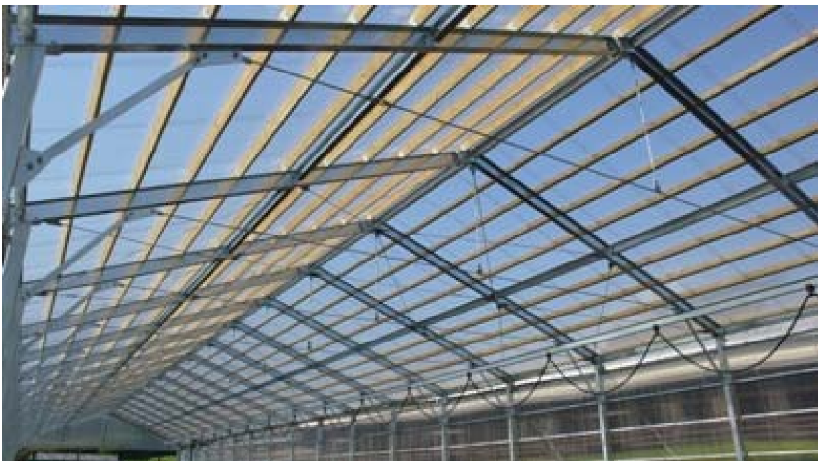
【堆肥舎屋根】屋根を支える母屋の材料にヒノキを使用
