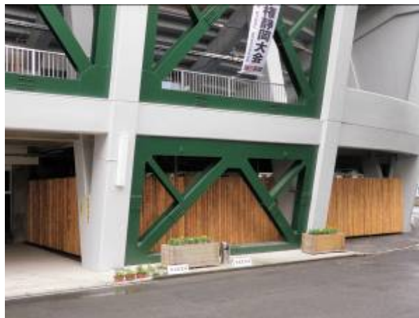
【設備機器の目隠し】間伐材の丸太を使用
