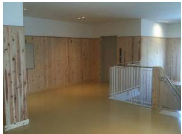
【2階 階段、エレベーター付近】廊下、階段を木質化
