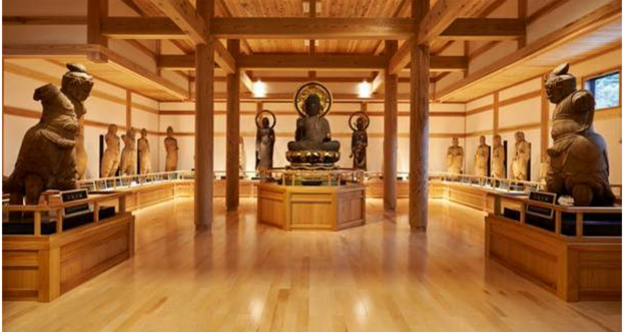
【展示館内部】構造材、天井、手すり、仏像の台座など県産材が随所に使用されている
