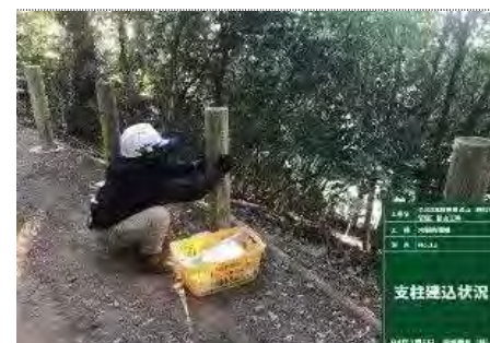
【施工状況】 支柱建込状況
