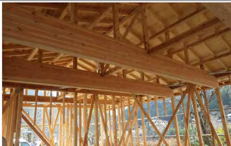
【木造軸組み状況】
