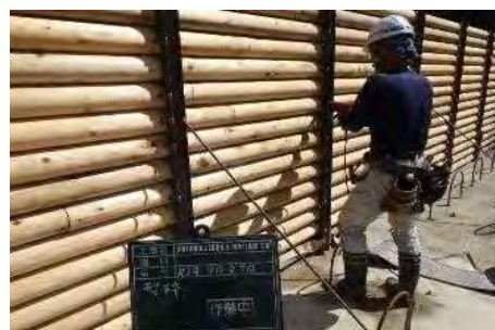
【施工状況】型枠の設置
