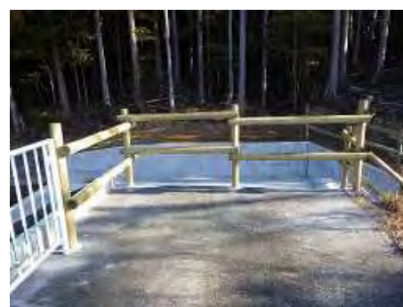
【ため池堤防天端に設置した木柵】
