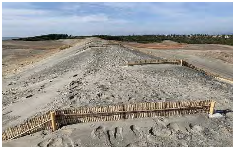
【堆砂垣設置状況】
