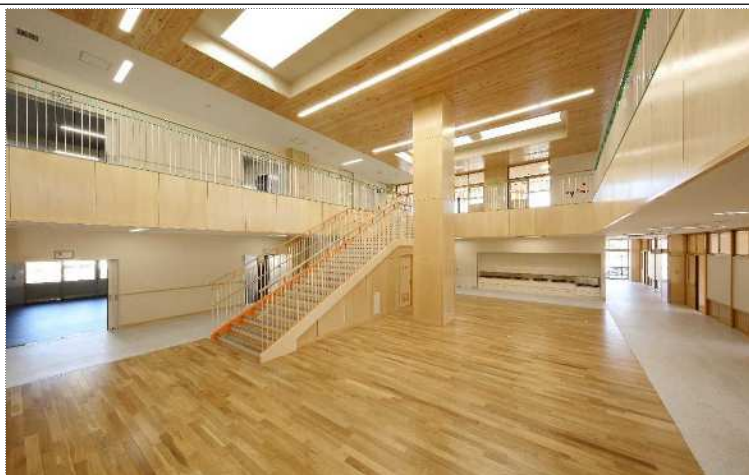
【吹き抜床・天井・柱型木質化】
