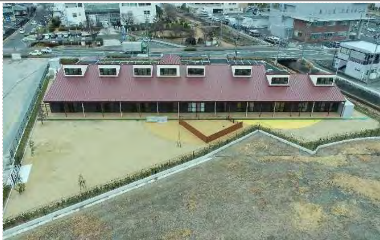
【建物南面外観】
