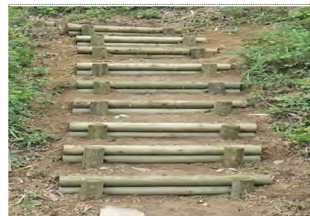
【木製階段の改修】
