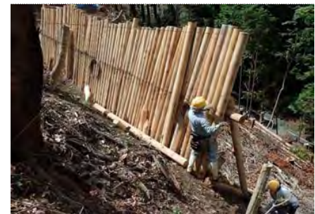
【設置作業状況】
