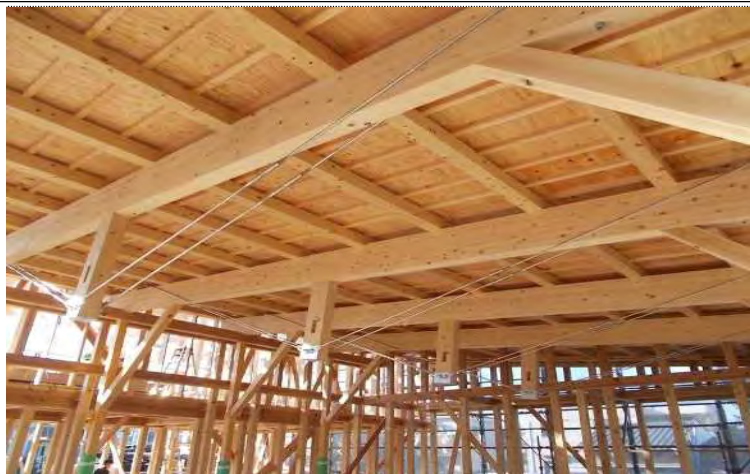
【ホール 建設中の様子】
