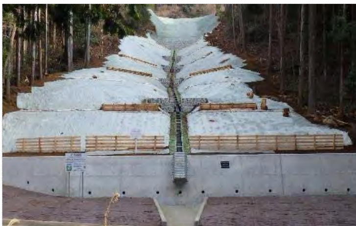
【柵工】正面の様子
