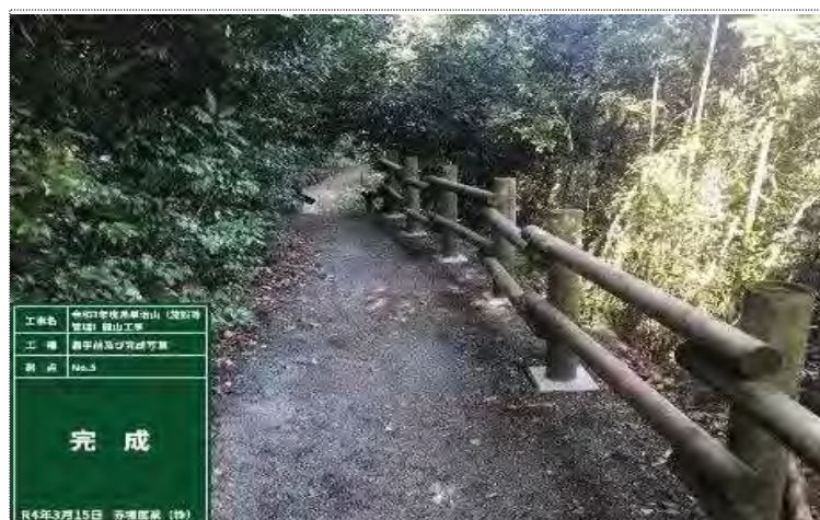
【木製防護柵】 完成状況
