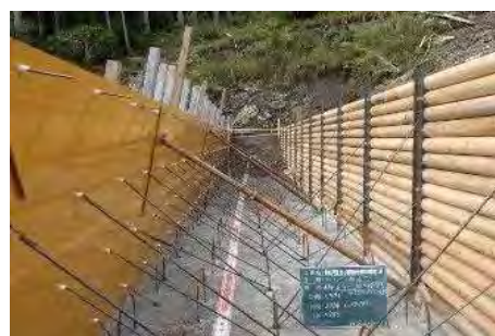
【施工状況】型枠設置完了
