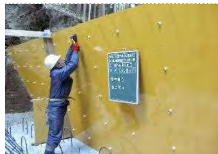
【施工状況】 合板型枠設置状況
