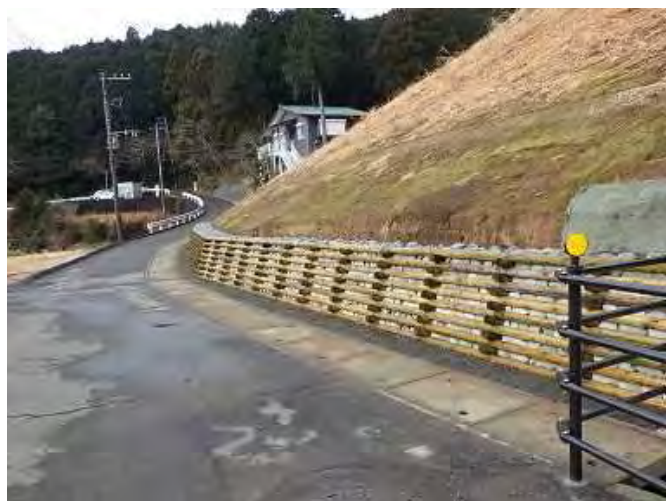
【木製校倉式土留工】
