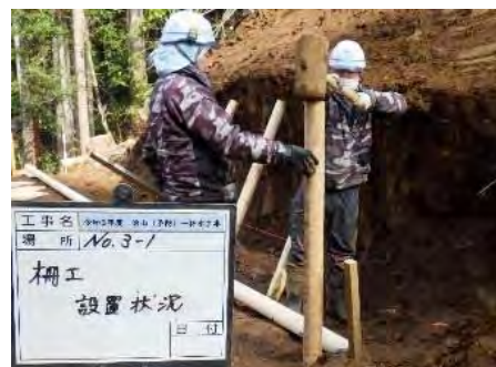
【設置状況】杭打込み
