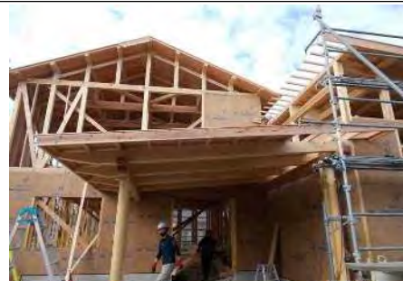
【建設中の様子】
