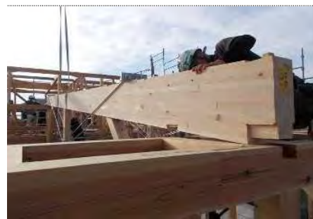
【建設中の様子】
