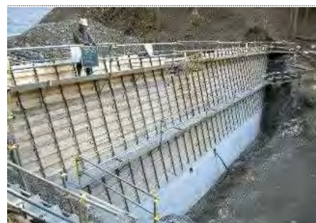
【施工状況】 合板型枠設置状況
