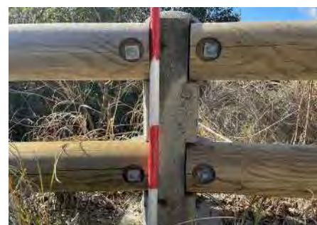
【木製ガードレール工(支柱接続部)】
