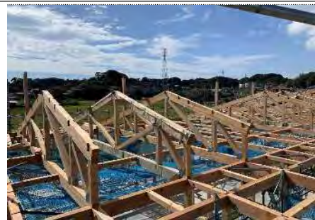
【建物屋根(工事中)】
