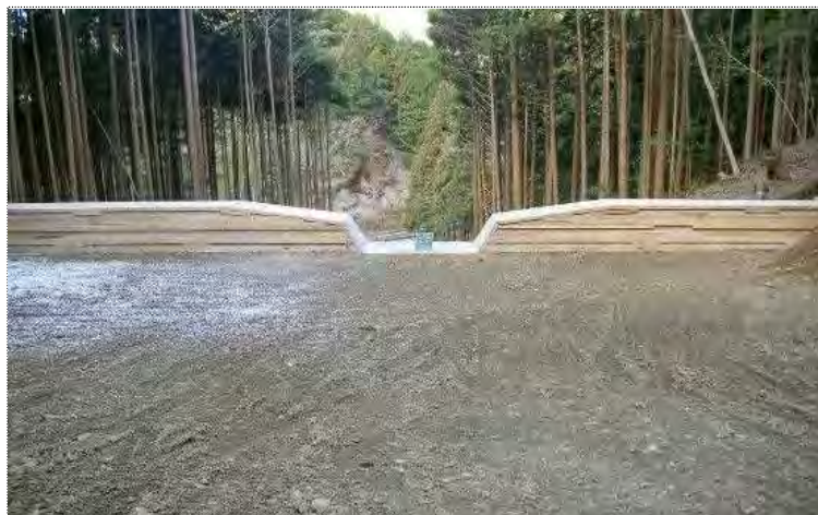
【谷止工完成】 谷止工背面の状況
