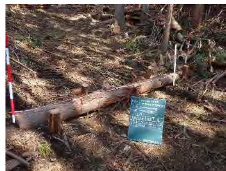
【土砂流出防止柵 1段積み】
