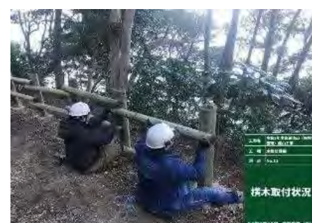
【施工状況】 横木取付状況
