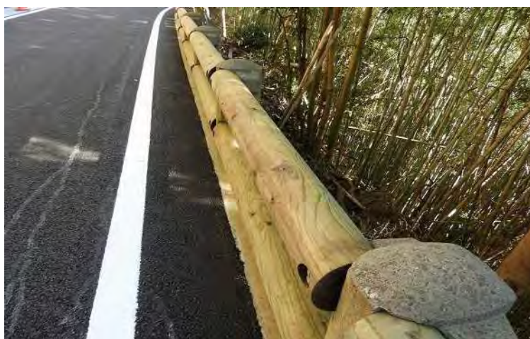
【木製ガードレール工(車線内から)】
