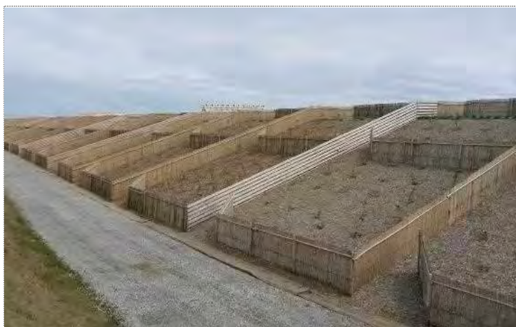
【設置状況(全景)】
