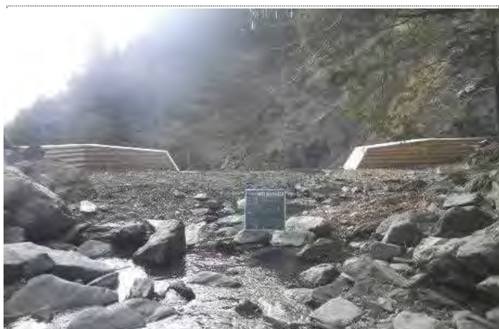
【谷止工背面の状況】
