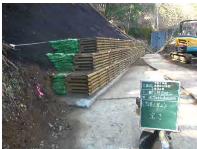
【木製枠工(簡易土留工)設置状況】
