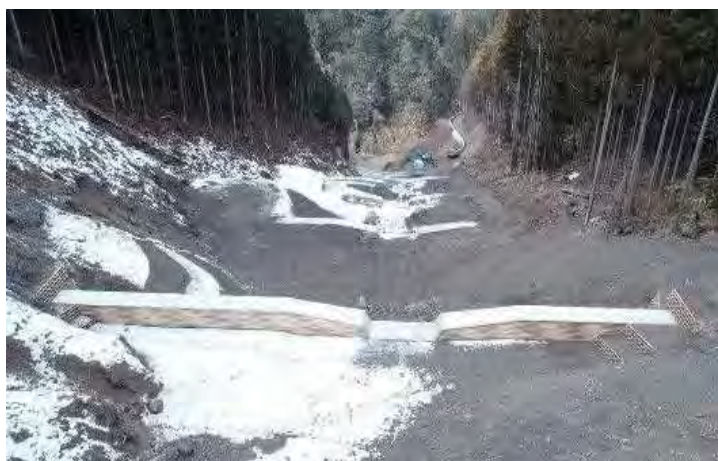
【谷止工完成】 谷止工背面の状況
