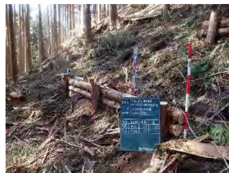
【土砂流出防止柵 2段積み】
