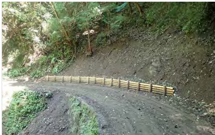
【施工した木柵工(全景)】
