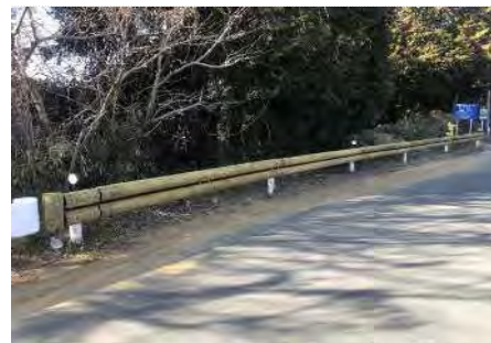
【国道1号線から林道入口付近】
