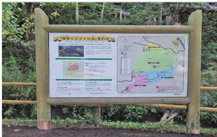
【表示板の改修(支柱・横木を交換)】
