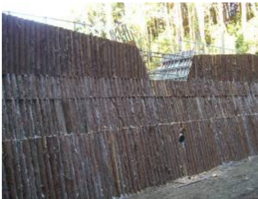
【施工後の状況】
