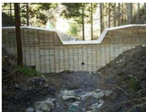
【施工後の状況】
