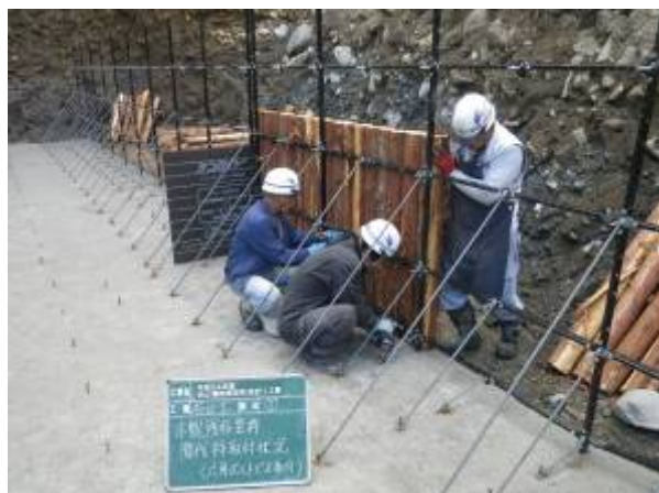
【施工状況①】
