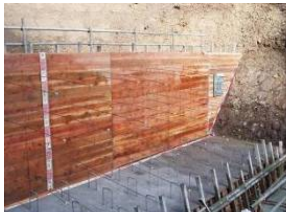
【組立施工中の状況】
