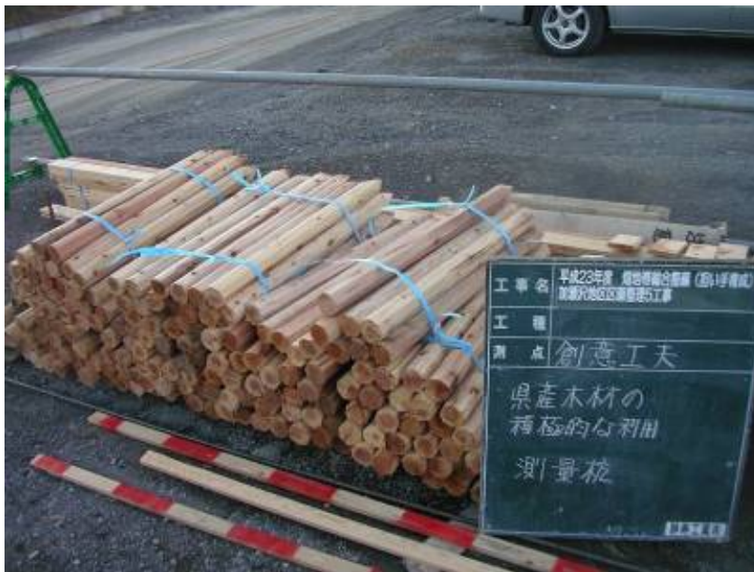
【測量杭・丁張材】
