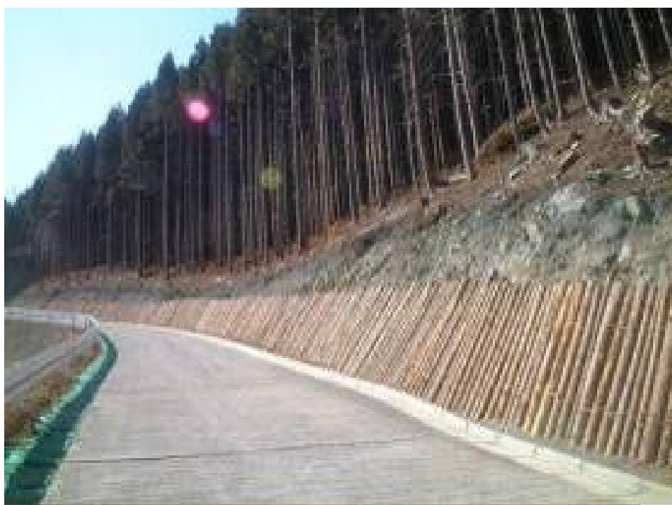
【施工後の状況】
