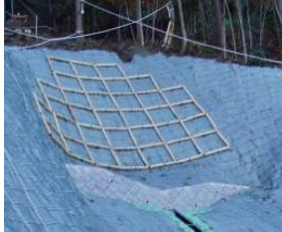
【施工後の状況】
