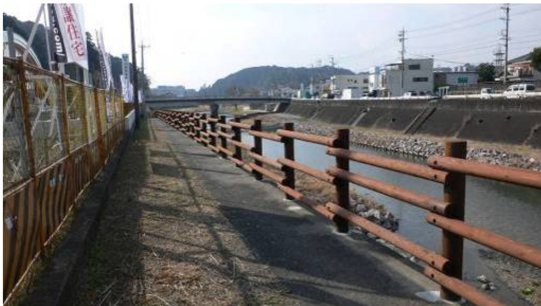
【転落防止柵工】一級河川二俣川（浜松市）
