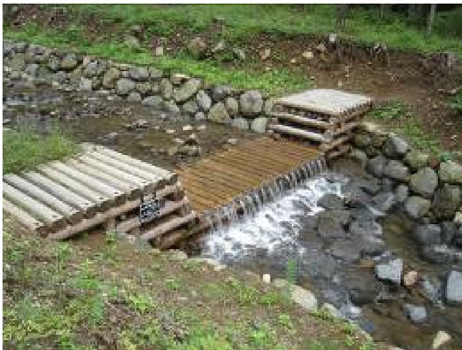
【完成後の状況】
