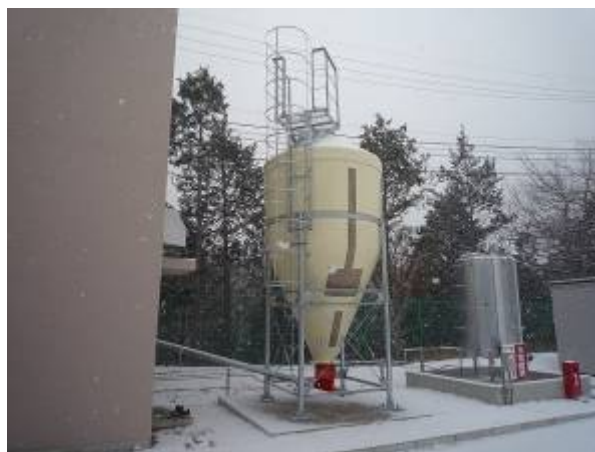
【木質ペレットの貯蔵庫】
