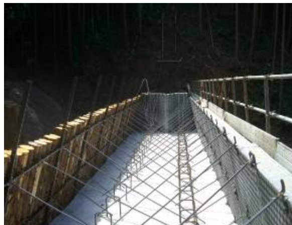
【施工状況②】
