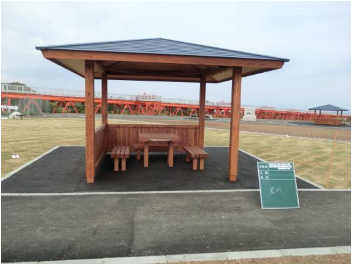
【空港東側展望広場】周囲の景観によく調和している
