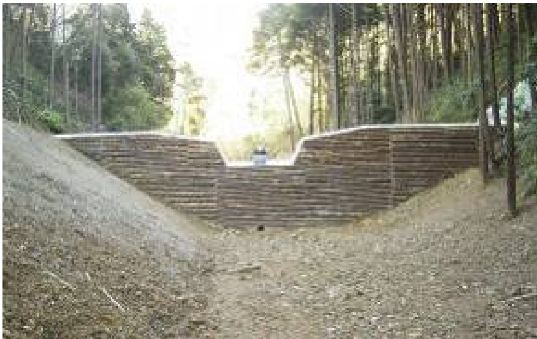
【施工後の状況】
