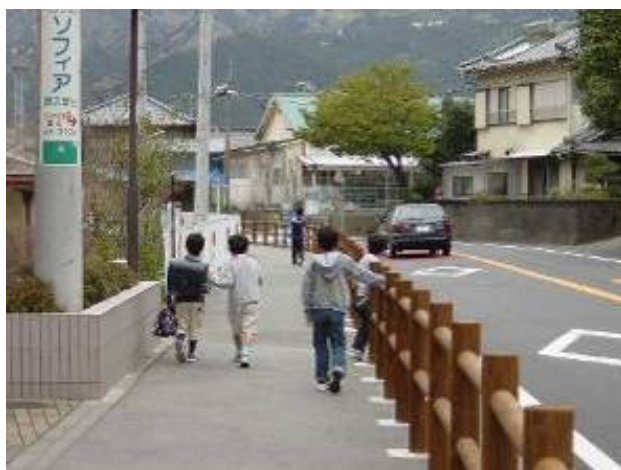
【横断防止柵】県道 中大見八幡野線（伊東市）
