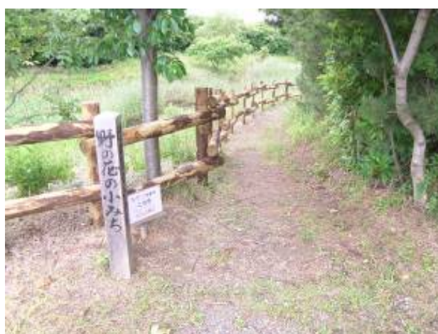
【立入防止柵】吉田公園（吉田町）
