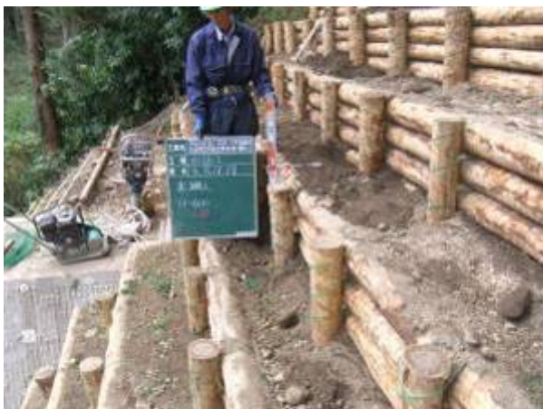
【近景】沼津市内浦重須（H23 施工事例）
