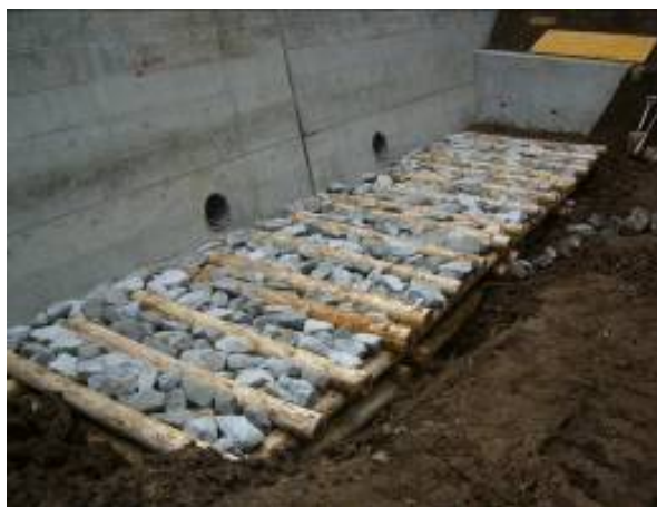
【完成後の状況】
