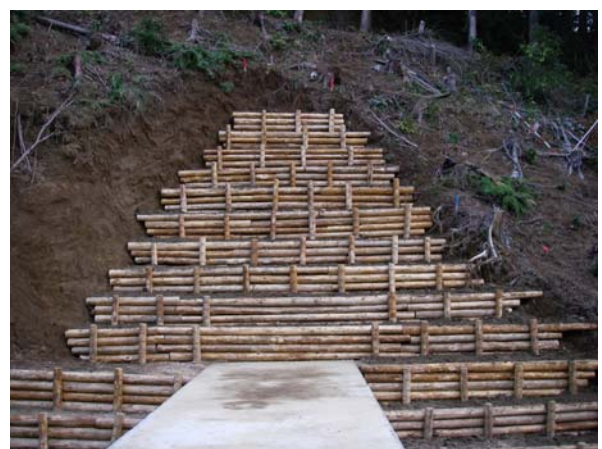
沼津市内浦重須（H21 施工事例）
