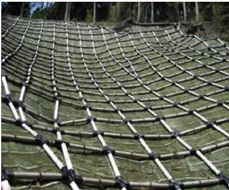
【施工後の状況】
