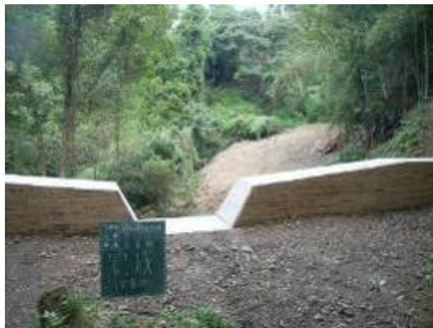
【施工後の状況】
