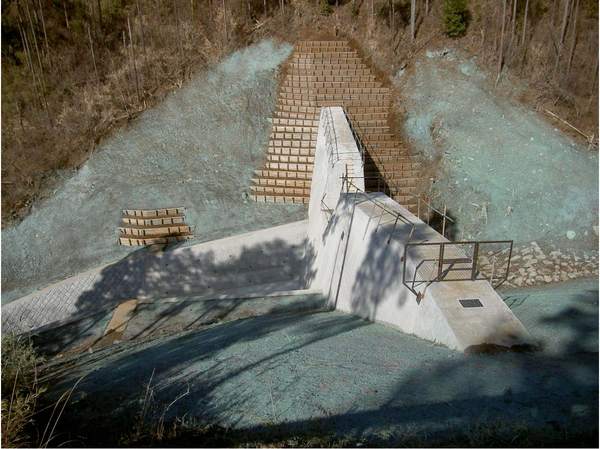
【全景】田方郡函南町丹那（H21 施工事例）
