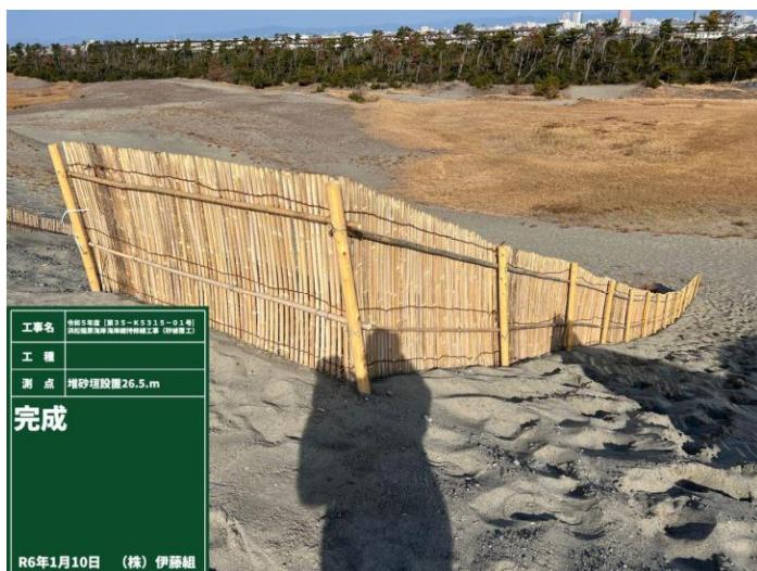
【堆砂垣設置状況】
