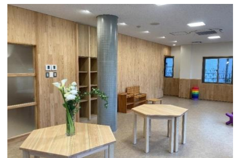
【壁不燃ヒノキ羽目板貼り】
