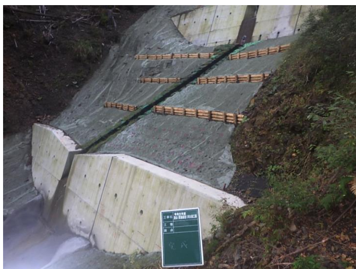
【丸太筋工】全景
