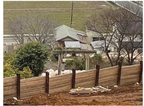
【仮設防護柵】上流側から撮影
