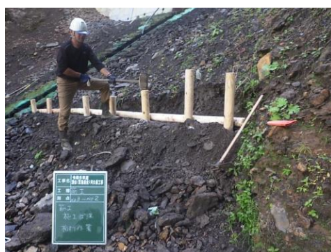
【施工状況(杭打ち)】
