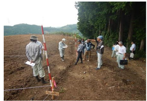
【道路境界杭の設置状況】
