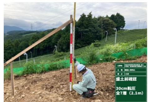
【法面丁張の設置状況】
