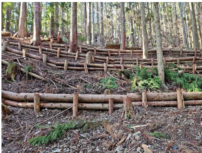
【丸太筋工】 全景
