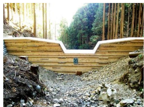
【谷止工】 残存型枠
