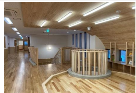
【内部天井不燃ヒノキ羽目板貼り、手摺ヒノキ縦格子】
