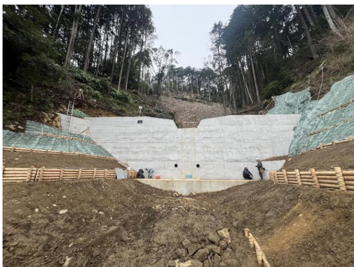
【丸太柵工・丸太筋工】 全景
