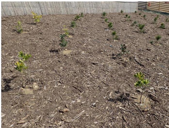
【マルチング敷均し】設置状況
