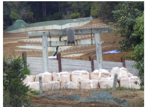
【仮設防護柵】下流側から撮影
