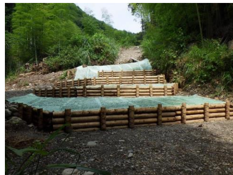
【重機搬入路復旧箇所】
