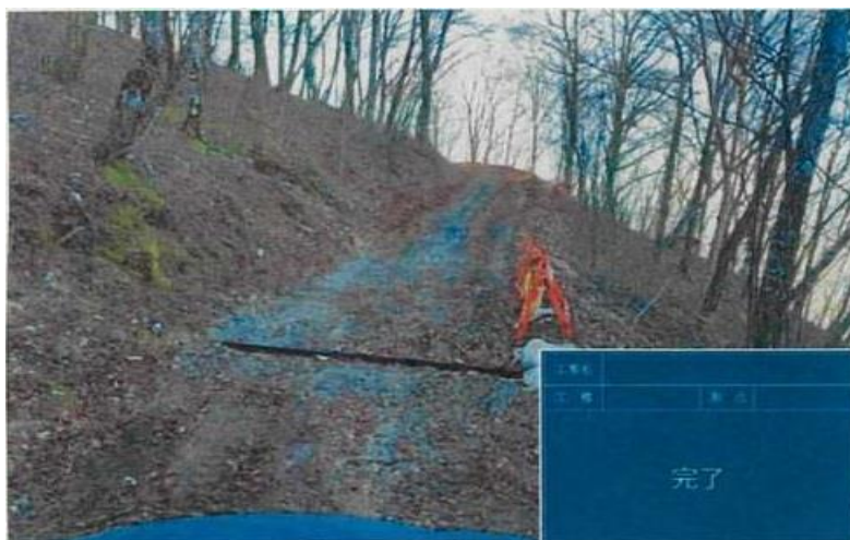
【水切り板設置】
