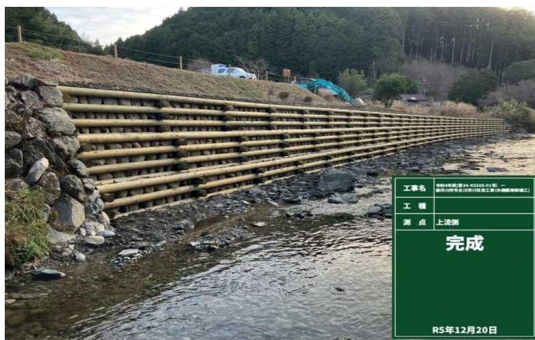
【木柵護岸完成】
