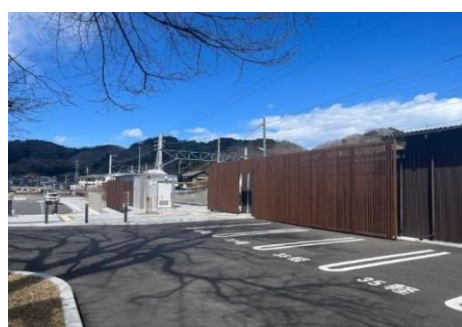
【木柵(縦格子目隠しフェンス)】
