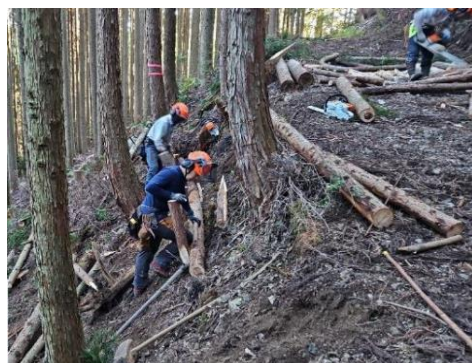
【丸太筋工】 施工状況
