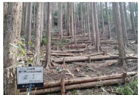
【土砂流出防止柵】 2段積み
