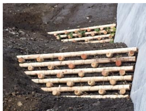
【丸太積間詰】上流側右岸
