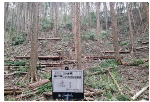
【土砂流出防止柵】 1段積み&2段積み
