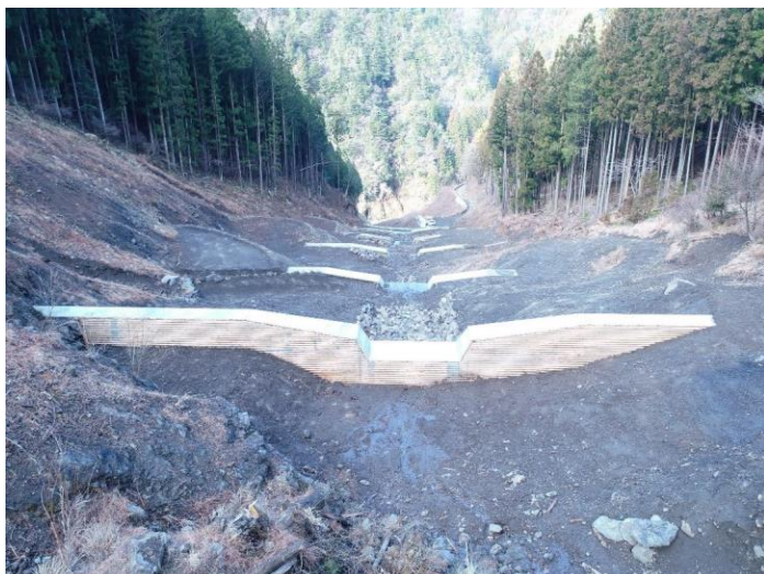
【木製残存型枠】全景
