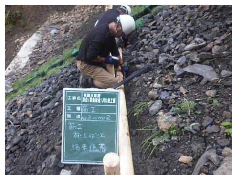
【施工状況(結束)】
