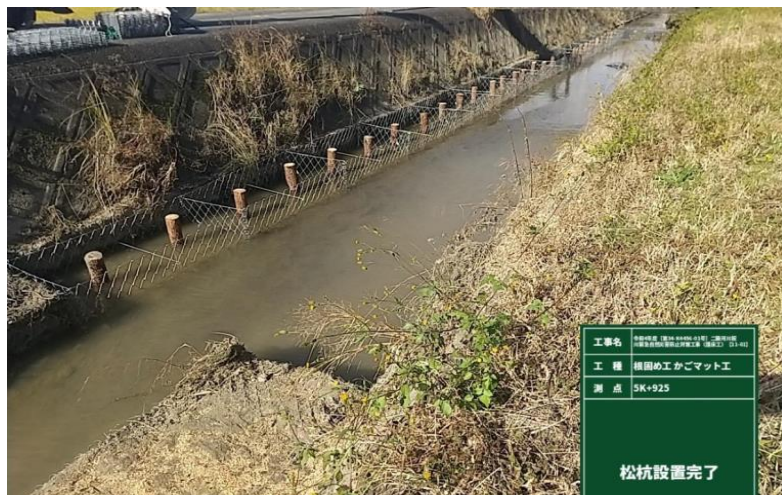
【松杭設置完了】
