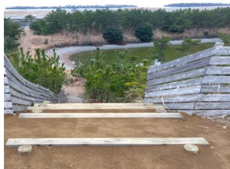
【上部】雨水対策であえて嵩上げた
