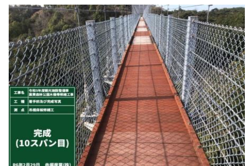
【吊橋(空の散歩道)床板交換】 全景
