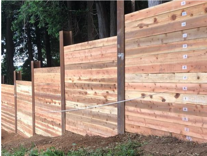
【仮設防護柵】設置
