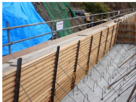
【木製残存型枠】施工状況
