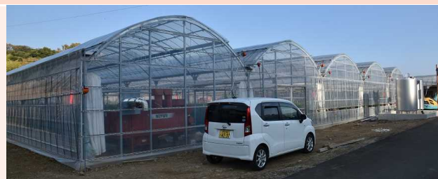
県事業で設置した新規施設
