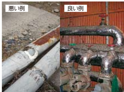
温湯配管の断熱を強化する
