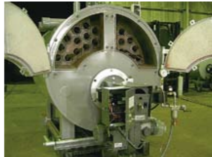
ボイラーの点検と清掃を行う
