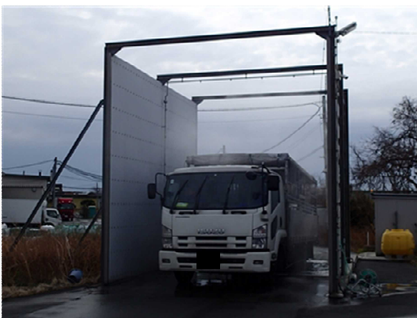
写真3 施設A ゲート式車両消毒装置（出口）
