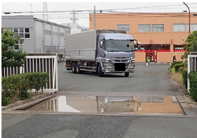
写真2 施設B 車両消毒槽（入口）
