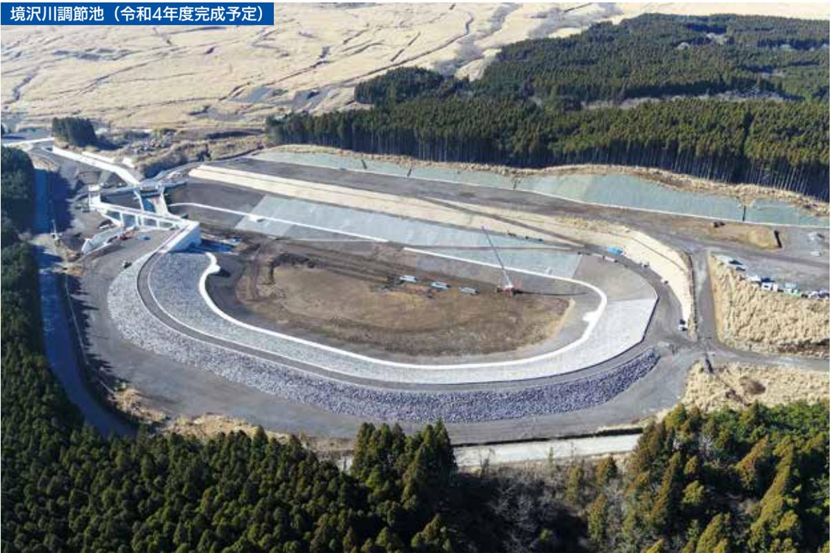
場 所：御殿場市印野地内 構 造：ロックフィルダム 堤 高：12.4m 総貯水量：23.5万 $\text{m}^3$
