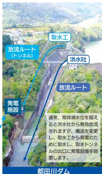
通常、常時満水位を超えると洪水吐から無効放流されますが、構造を変更し、取水工から発電のために取水し、取水トンネルの出口に発電設備を設置します。
