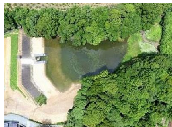
夜水沢池（完成）
