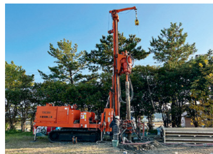
ボーリング機械一式
