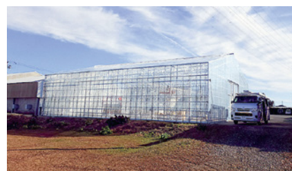
地中熱利用システム導入ハウス
