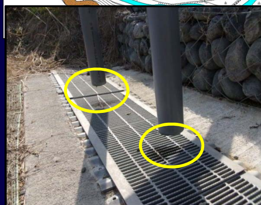
横ボーリング工の集水状況
