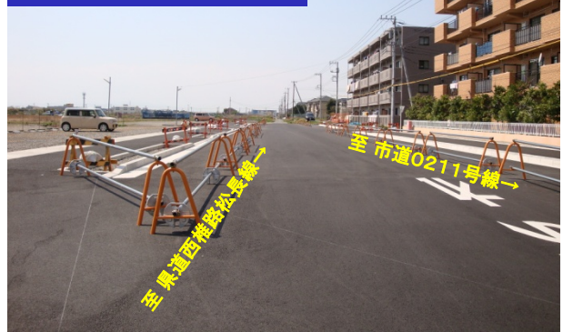
工事の進捗状況写真
