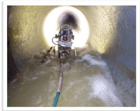
テレビカメラによる点検（小さい管の場合）
