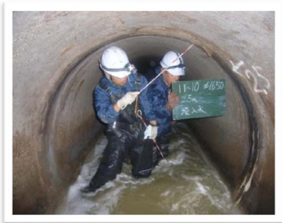
人力による点検（大きい管の場合）
