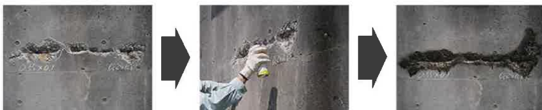
図 1.6.1 エポキシ樹脂系浸透固化材の塗布の事例
