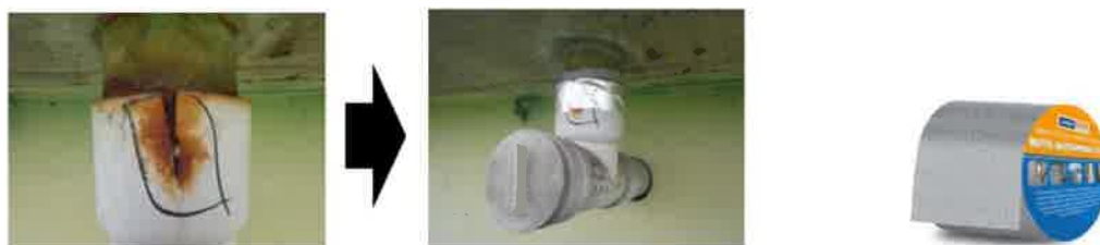
図 1.6.2 防水アルミブチルテープによる養生の事例
