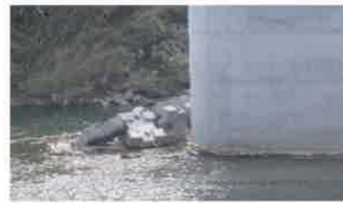
橋脚周辺の護床ブロックに変状が見られる。
