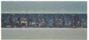
腐食度：B（グレード：III）
