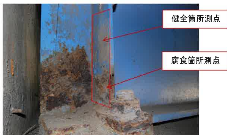
測定位置背面状況写真
